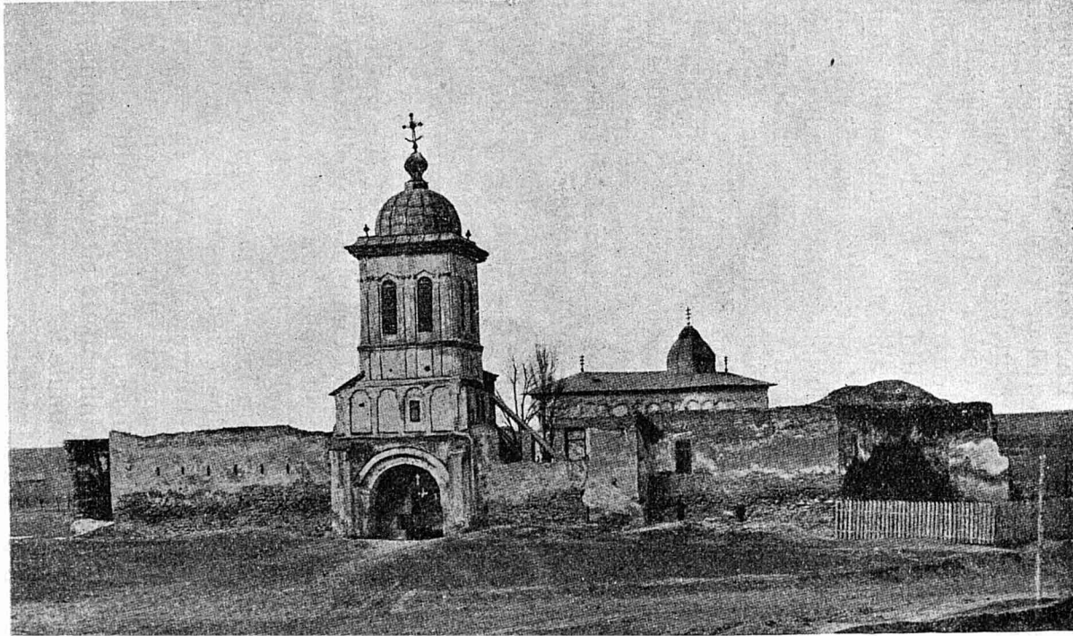
Foasta mănăstire Plumbuita (acum în reparație). Clopotnița și turnul sînt din secolul al XVII-lea.
