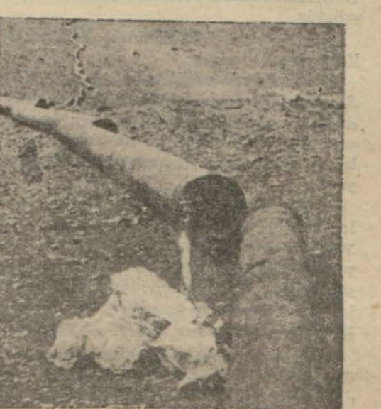
Birbirine raptedilerek tahtelâz döşenecek borular
