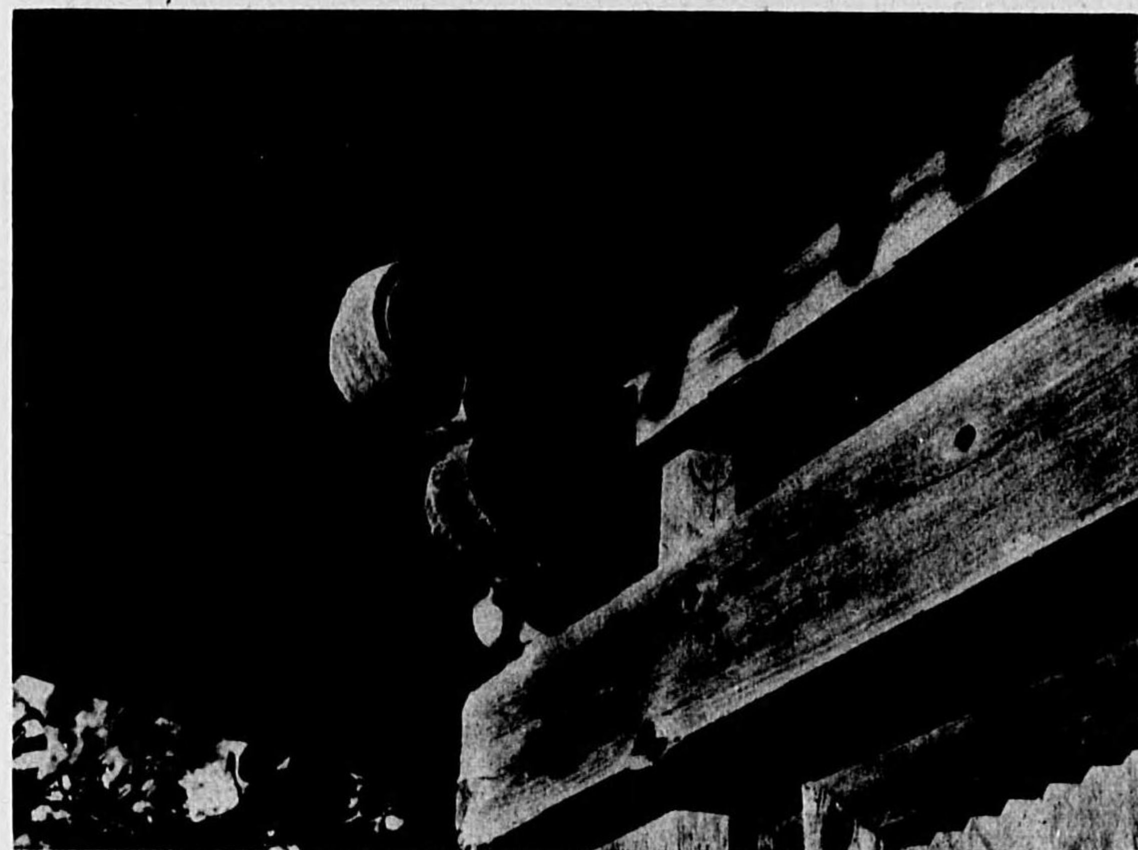
上、九四 官幣中社嚴嶋神社多寶塔初重軒一部（昭和七年三月三十一日） 下、九五 同 隅木鼻（昭和七年三月三十日） 上圖は東面中の間上の一部分で、此養腹だけが全體古く、中央に入れてある梵字「ウン」亦當初の儘である。支輪は室町になつては、この様にS字形のものがあつて差支はない。下圖には大きく寫つてゐる木鼻は頗る拙い形をしてゐる。
