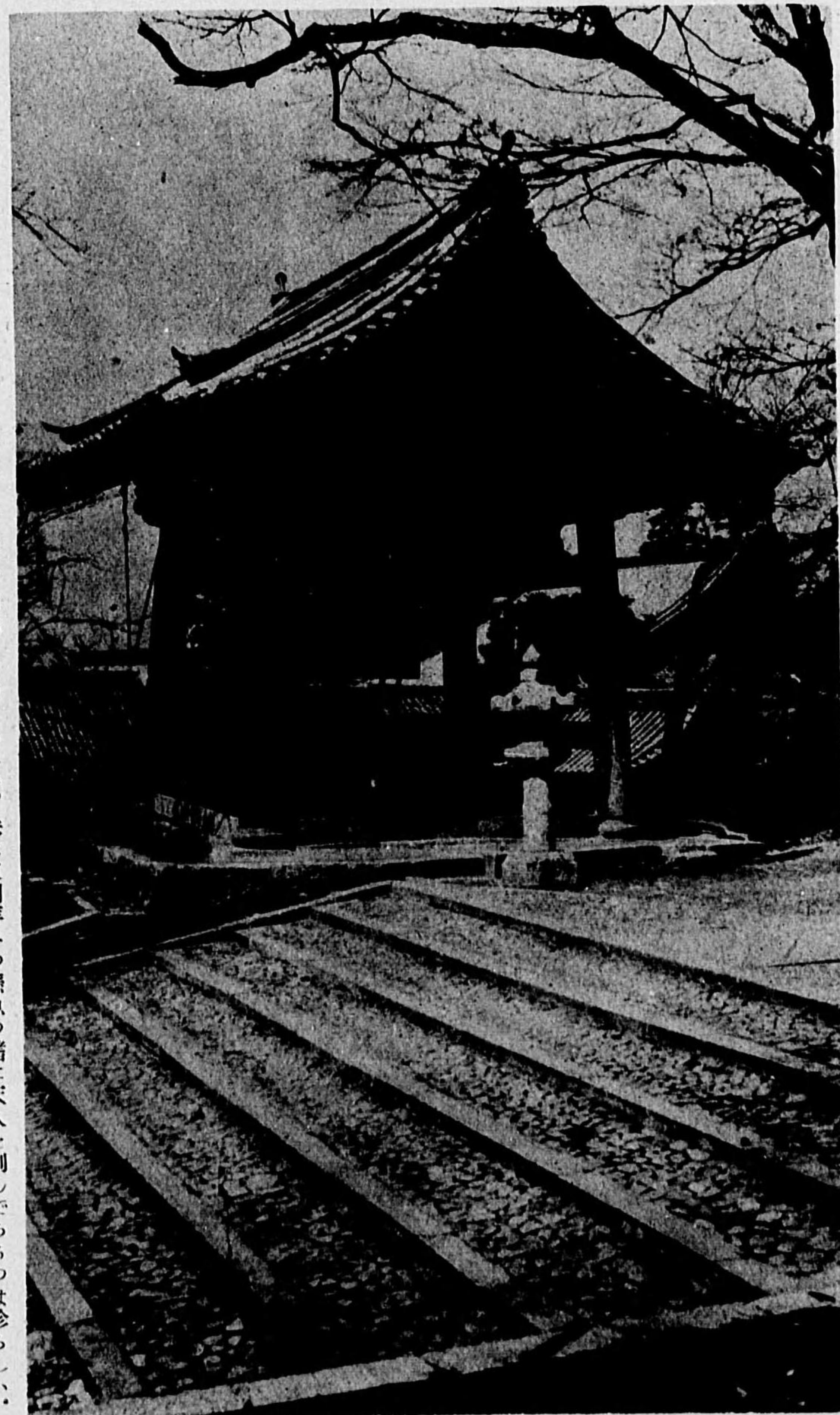
一七三 金戒光明寺鐘樓全景
