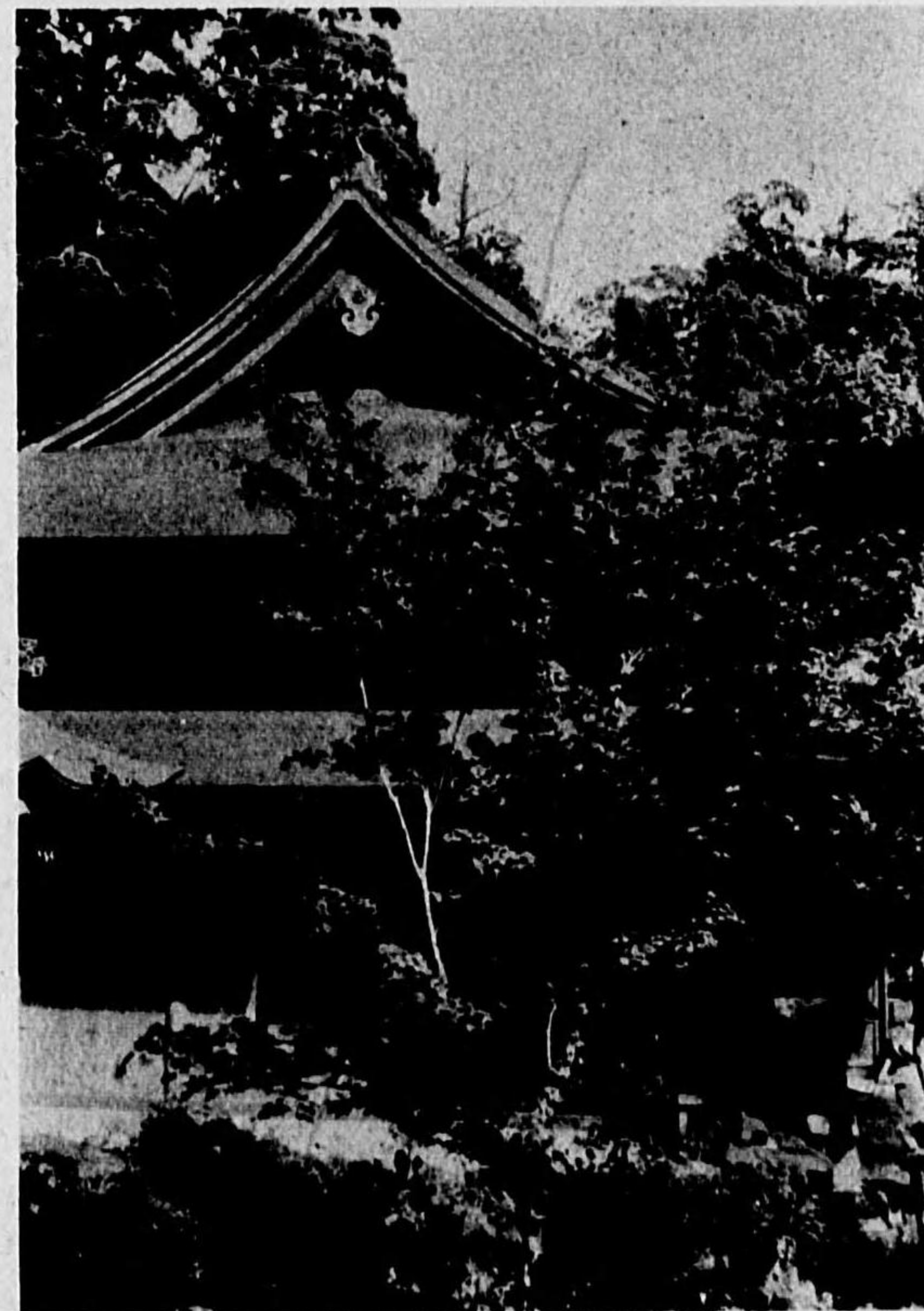
上、一五〇 定光寺本堂正面(修理前) (中野 藝術院) 下、一五一 同 側面(修理後) (昭和十六年七月三十一日) 修理前は上圖の様に上層は漸く軸部だけが出来ただけで、切妻造りの假屋根を架けてあつたが、先年修理の際推定復原をして、下圖の様に立派に室町式にでき上つた。細部の様式に就いては多少意見がなくもないが、概してよくできてゐる。
