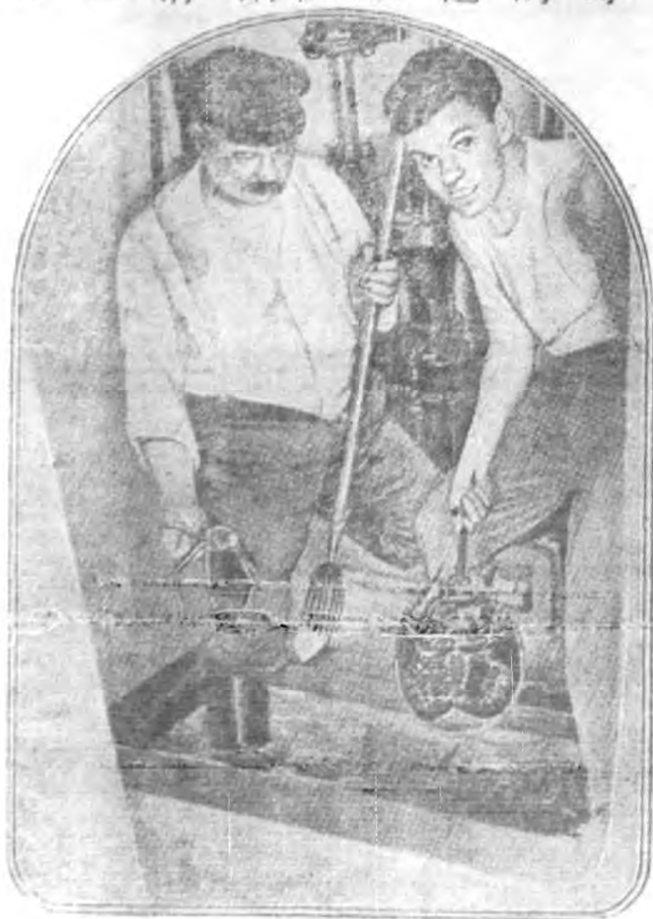
西門拉克探寶潛艇的壓緊空氣房內部的形狀圖中是表示開了水底門窺探海底動物的形狀。
