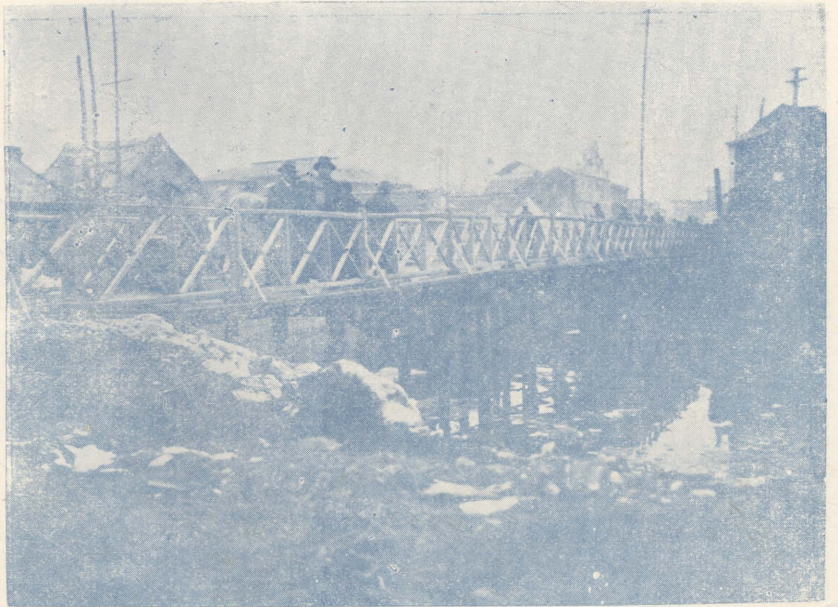
四 象 橋 旁 新 建 之 人 行 橋
