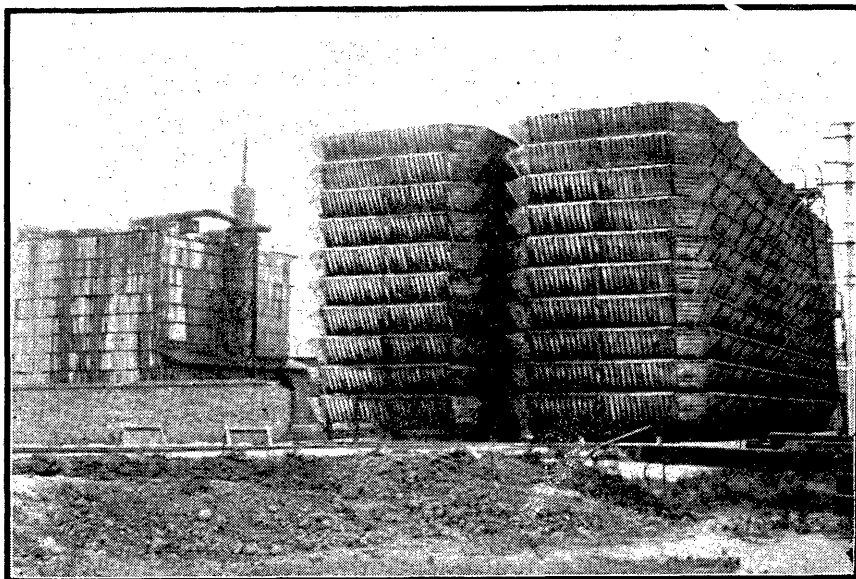
除氣塔 涼水塔
