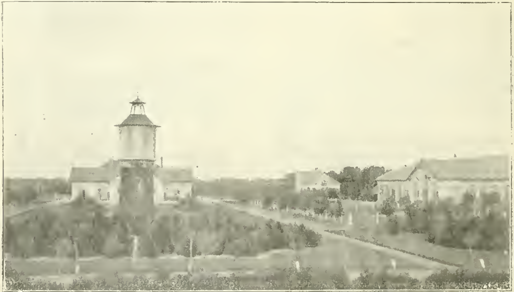
Fig. 6. — Bâtiments de la ferme de Magyárovar. — Vacheries, Manutention et Château d'eau.
