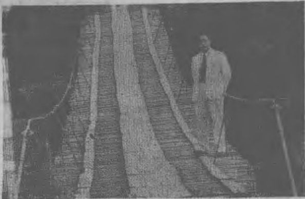
貫通二院之鐵索橋
