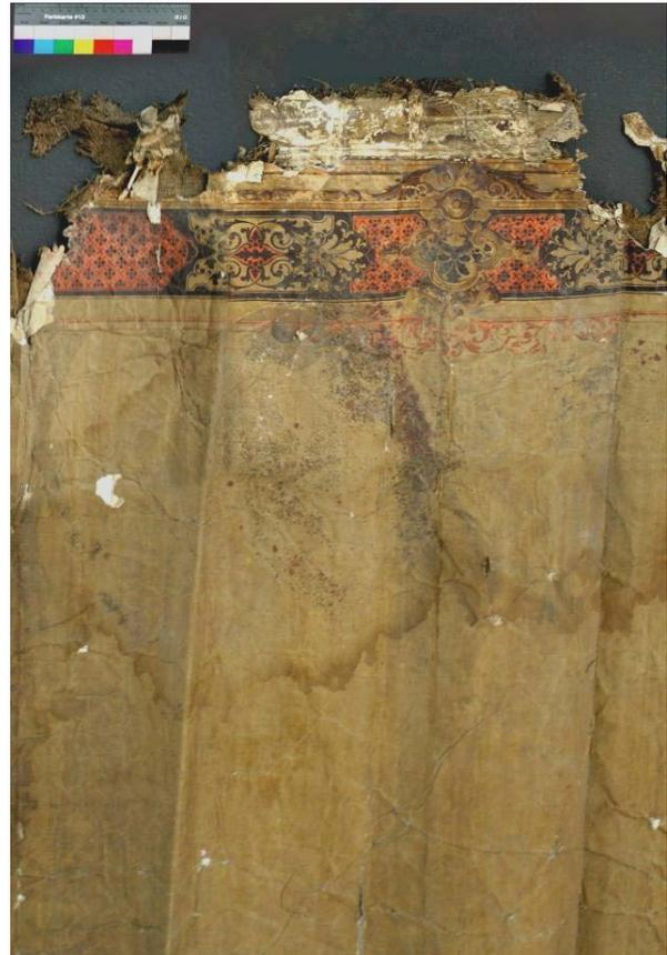
**Abb. 21**<sup>212</sup> Wasserränder, Stockflecken und Rotfäulepilze auf der Oberfläche des Tapetenelements TAP 14C. Zudem Druckschichtverluste auf dem Gesims.
