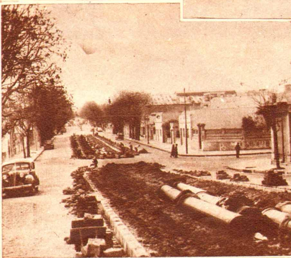
Por aquí pasaba un ramal ferroviario en desuso. Veinte barrios pidieron durante veinte años que allí se hiciera una calle. Fué necesario que llegase Perón para que se construyera esta Avenida del Justicialismo: 9 kilómetros en el corazón de la ciudad... 20 metros de ancho.
