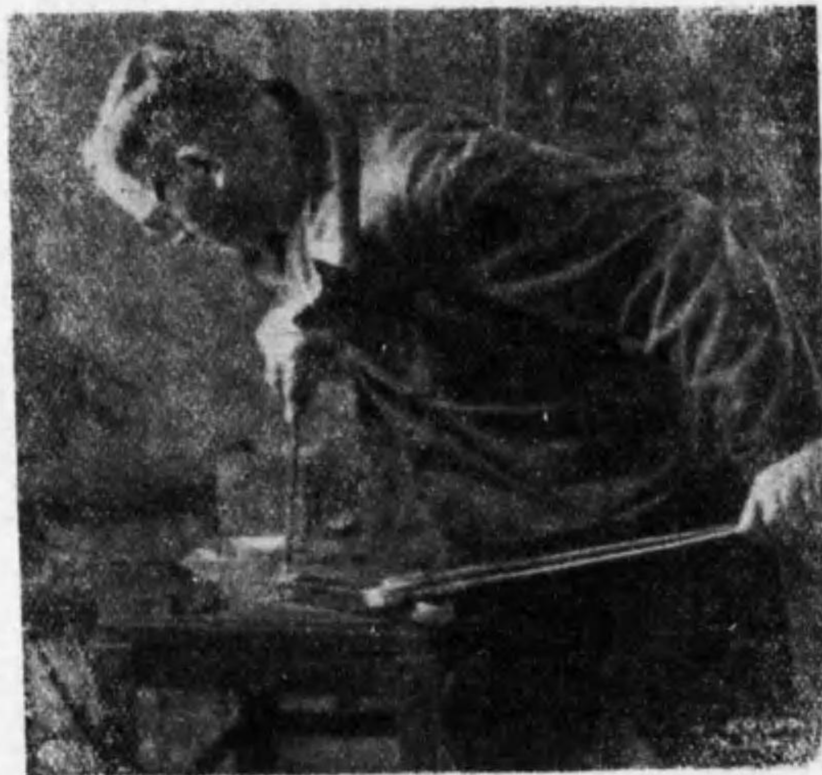
第53圖 鍍付後に於けるウイディアチップの壓着
