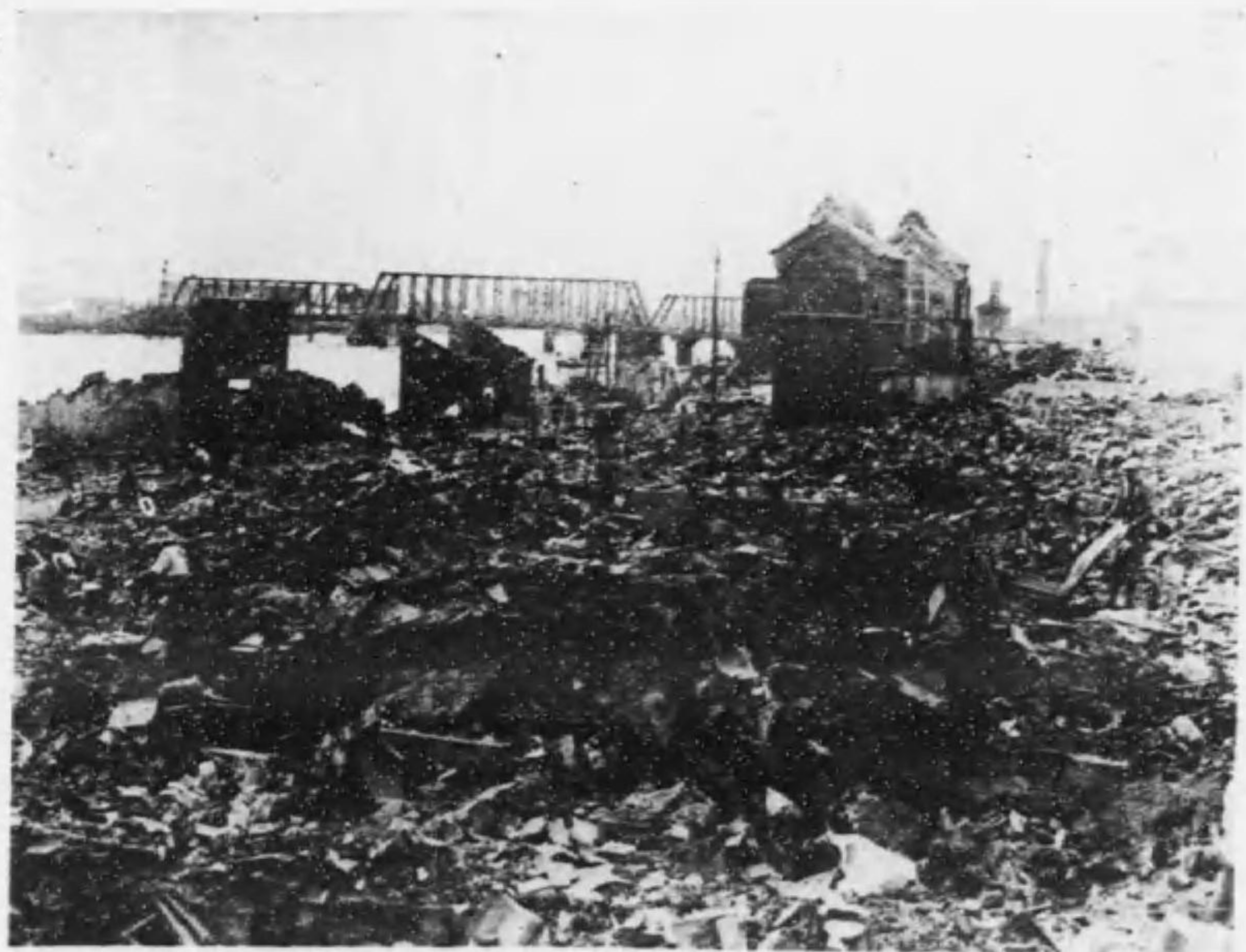
駒形附近の跡跡より 既橋を望む
