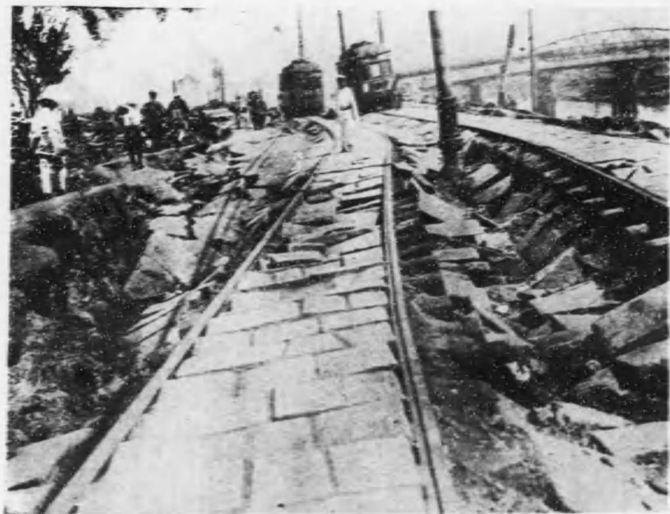
横濱足曳町市電線路の大破損
