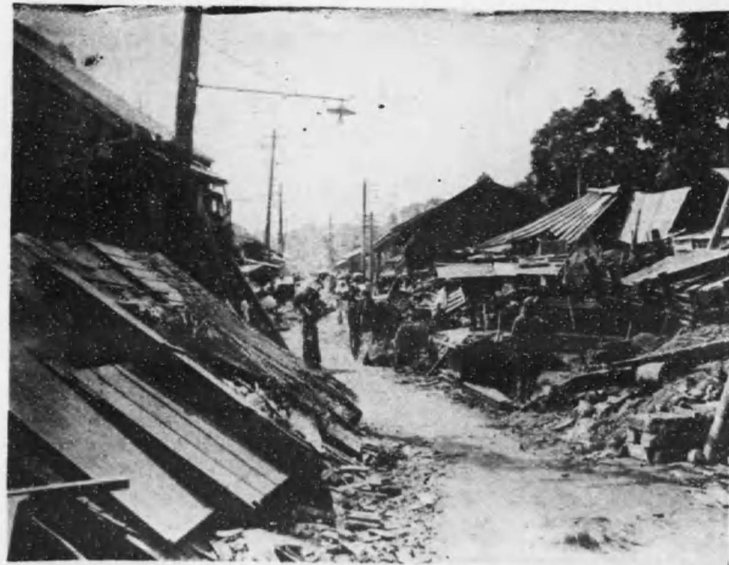
横須賀深里通りの倒壊家屋
