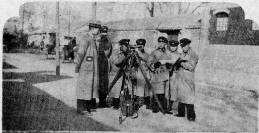
← 水平儀測量實習
