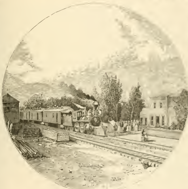
R. R. STATION, HUMBOLDT, NEVADA.
