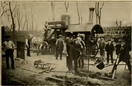
POURING A JOINT.
