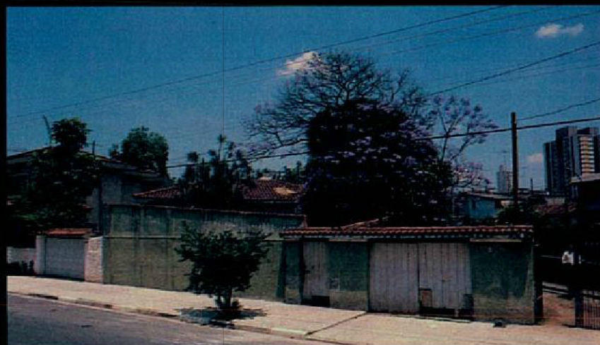
OBRA DO INQUILINO — O locatário não tinha dinheiro para pagar o aluguel, mas chegou a construir um muro em frente da casa
