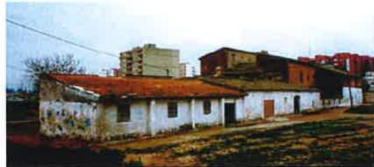
Las alteraciones en el cuerpo principal son de tal envergadura que han desvirtuado la arquitectura del edificio, alterando la sección original y la cubierta del edificio principal, desvirtuando el perfil del edificio y su aspecto en fachada. Se conserva en cambio la estructura original, las trazas y muros, quizás también algunos forjados originales, así como las escaleras de acceso a las plantas altas, o bien parte de ellas.
