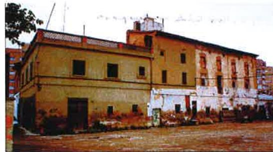
De la arquitectura de la casa principal hay que distinguir en planta baja las fábricas de ladrillo, los arcos de medio punto construidos con ladrillo en ambas fachadas, tanto la exterior, como la que cierra al patio; mas un arco carpanel central de grandes dimensiones, impostado en su arranque con dos pequeños salientes de ladrillo. las dimensiones de este arco son tales que le proporcionan una gran diafanidad al espacio interno de la alquería en esta planta baja
