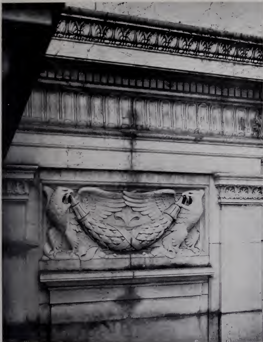
155. — Decorazioni dei cortiletti dietro le scalee centrali
