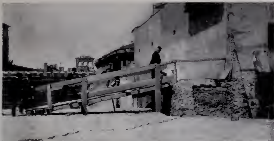
80. — Guido Baccelli visita le demolizioni
