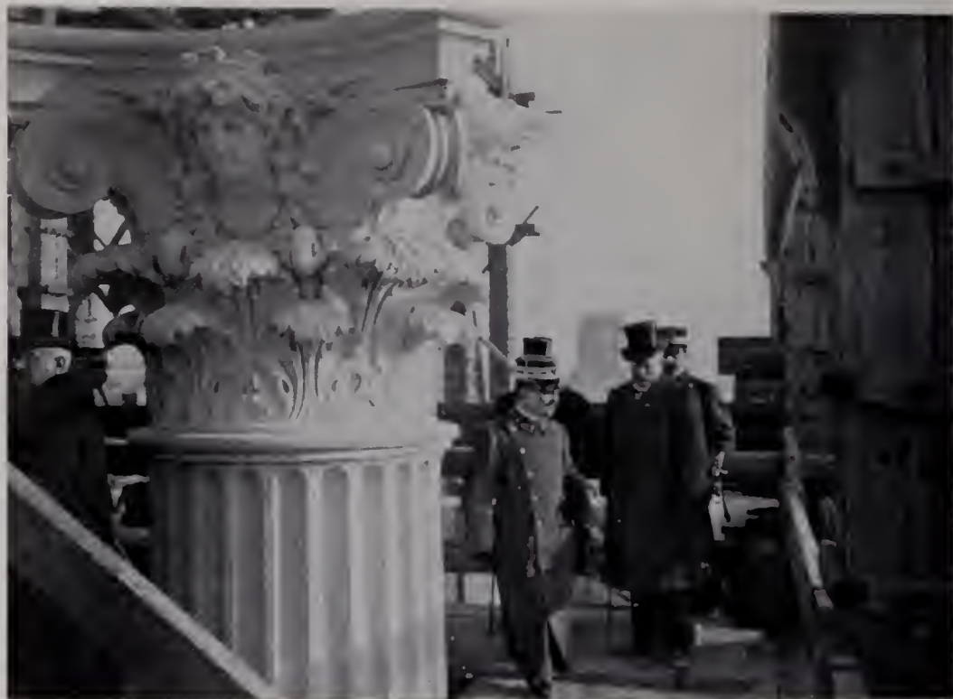
293. — Vittorio Emanuele III visita i lavori nel fondo a sinistra il Comm. A. Rocco, poi un generale del seguito, S. M. il Re, l'Architetto G. Koch, il generale Brusati
