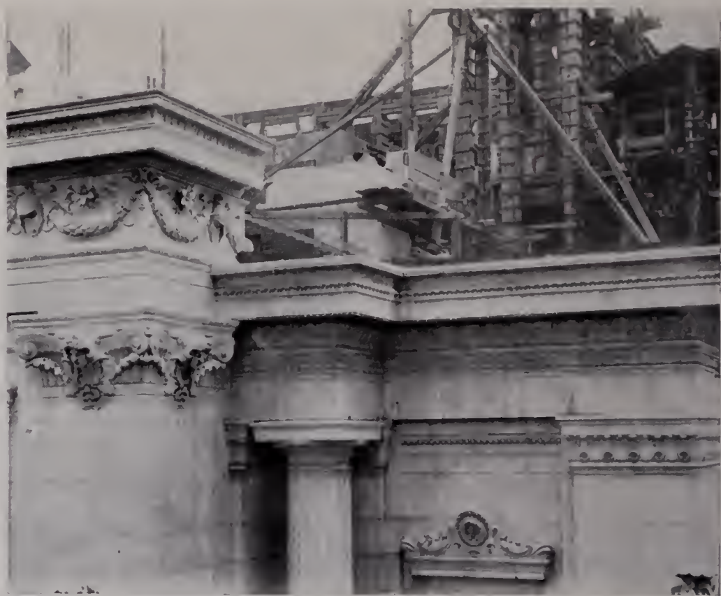
105. — Angolo dei muri perimetrali (parte superiore)
