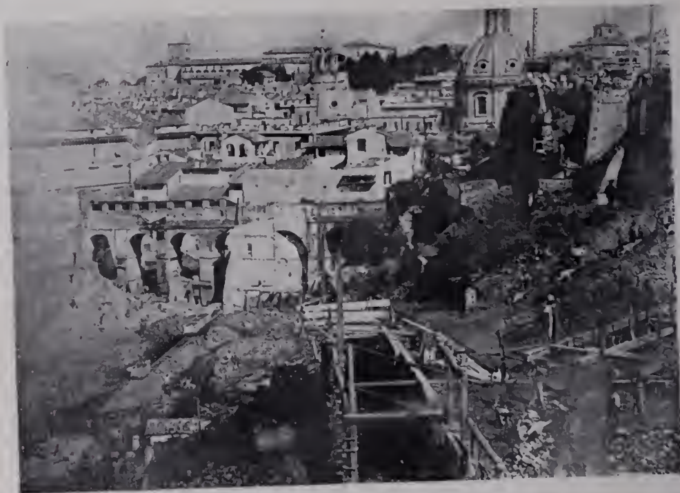
76. — Sbancamento del Colle Capitolino come al n. 74
