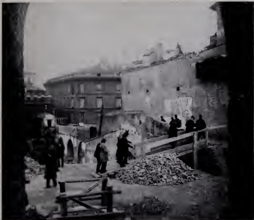
84. — La Commissione Reale visita le demolizioni
