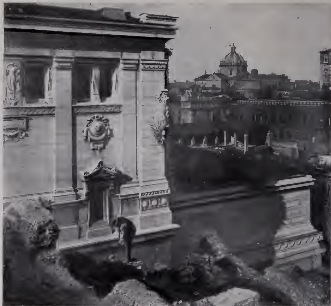
113. — Muro perimetrale a sinistra
