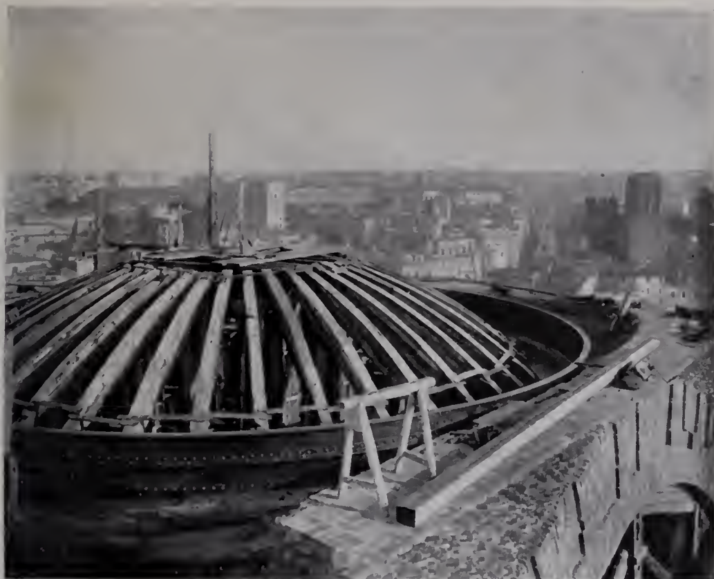
254. — Costruzione della gran cupola del propileo sinistro
