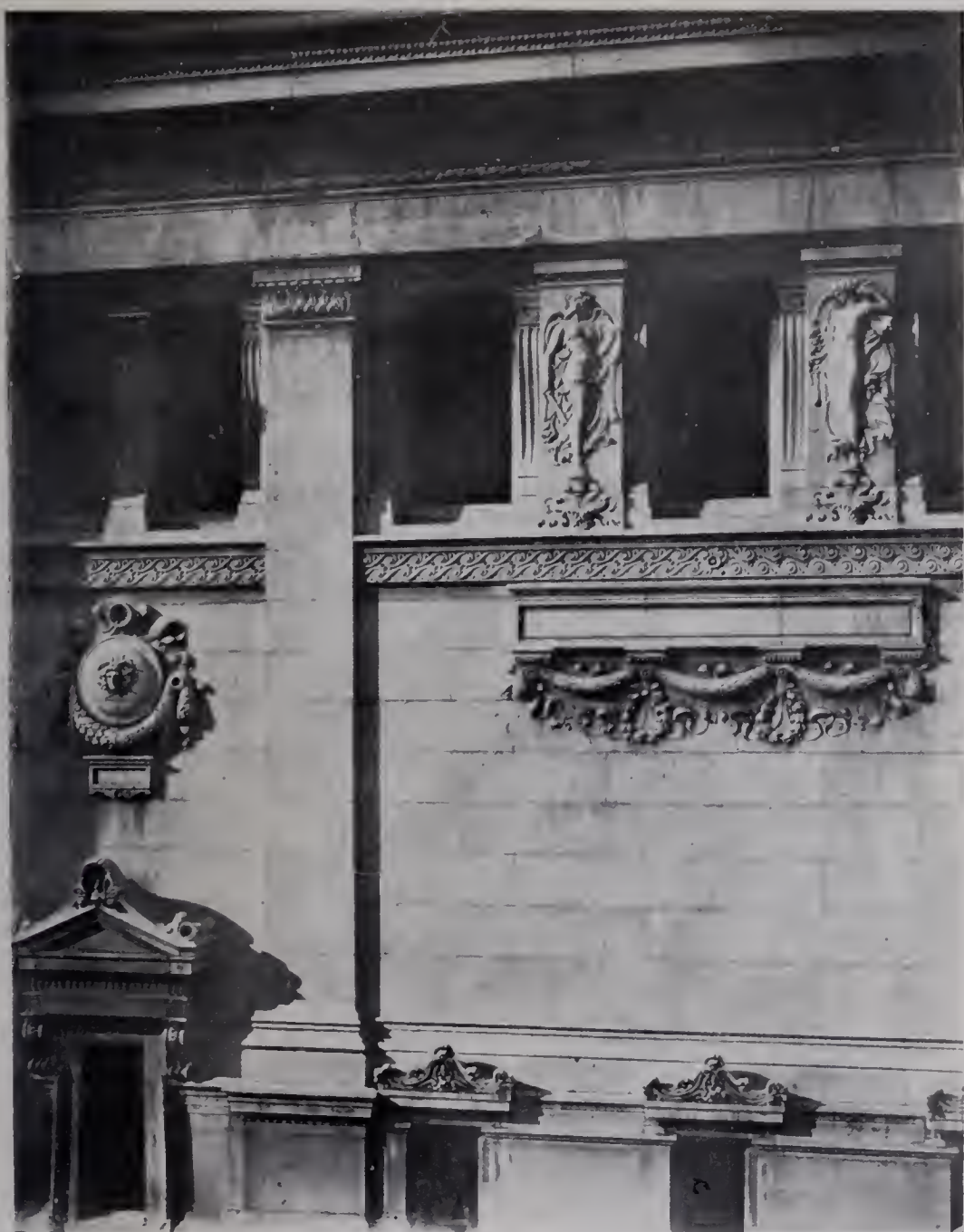
131. — Muri perimetrali. Decorazioni complessive
