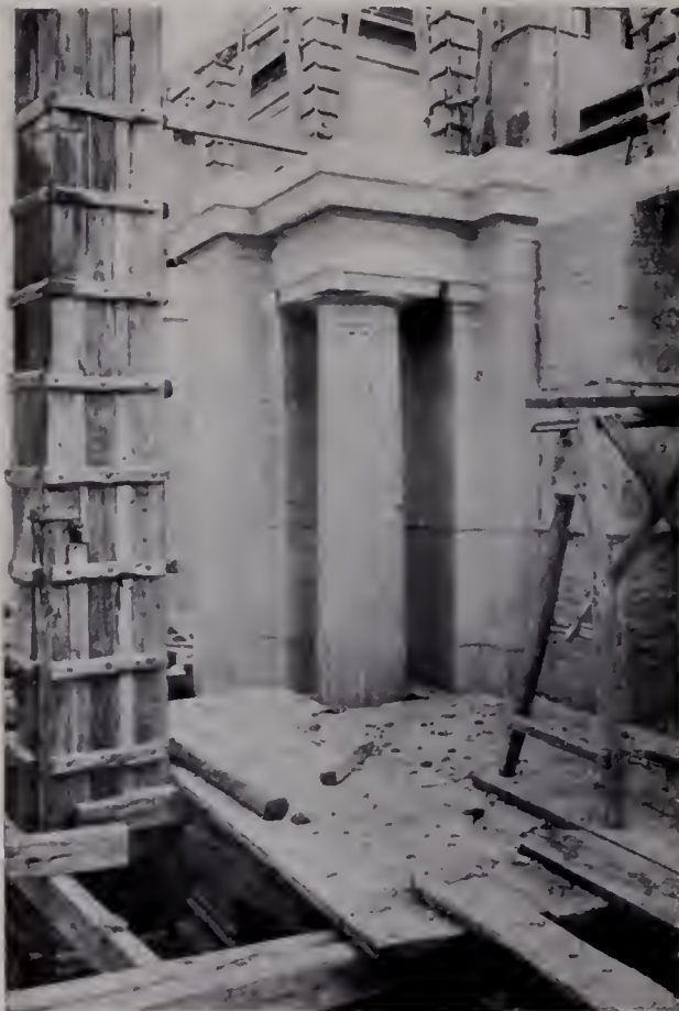
98. — Angolo dei muri perimetrali
