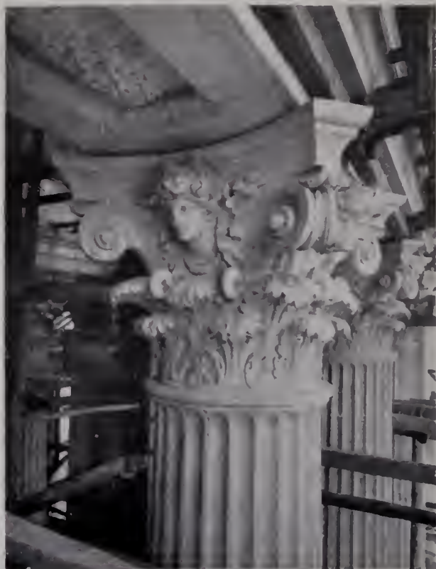
235. -- Il primo masso della trabeazione a posto
