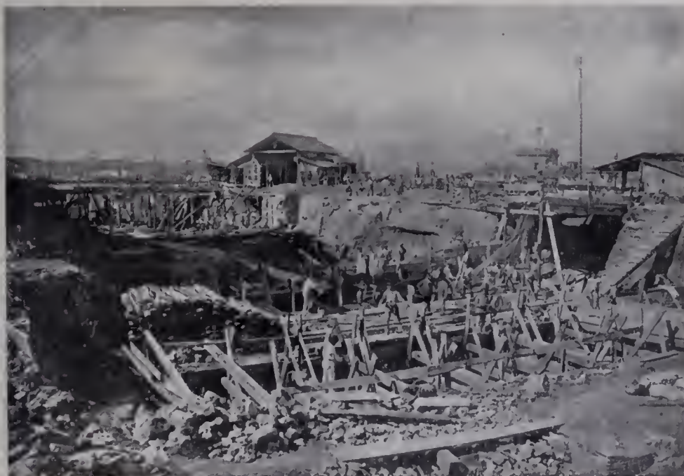
74. — Sbancamento del Colle Capitolino. Cantiere superiore
