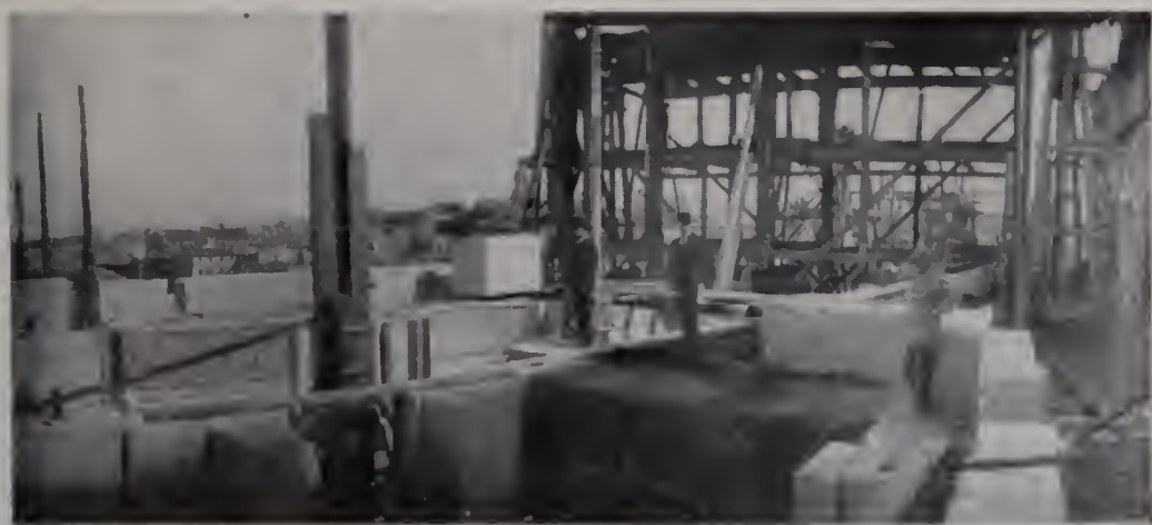
279. — Lo stibolate in costruzione
