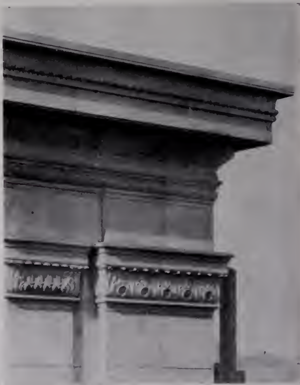
135. — Cornicione dei muri perimetrali
