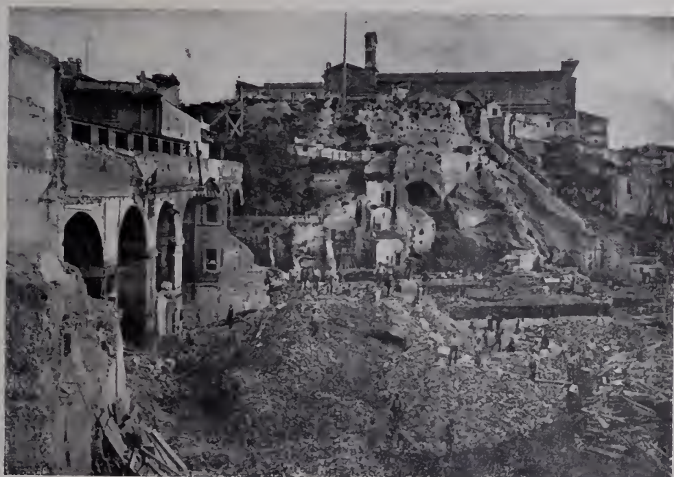
78. — Sbancamento del Colle Capitolino. Cantiere inferiore
