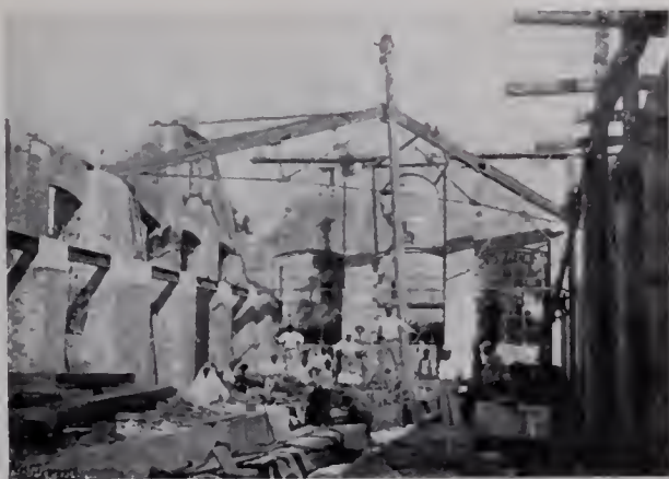
87. — Il primo capannone costruito nel cantiere di Porta Maggiore
