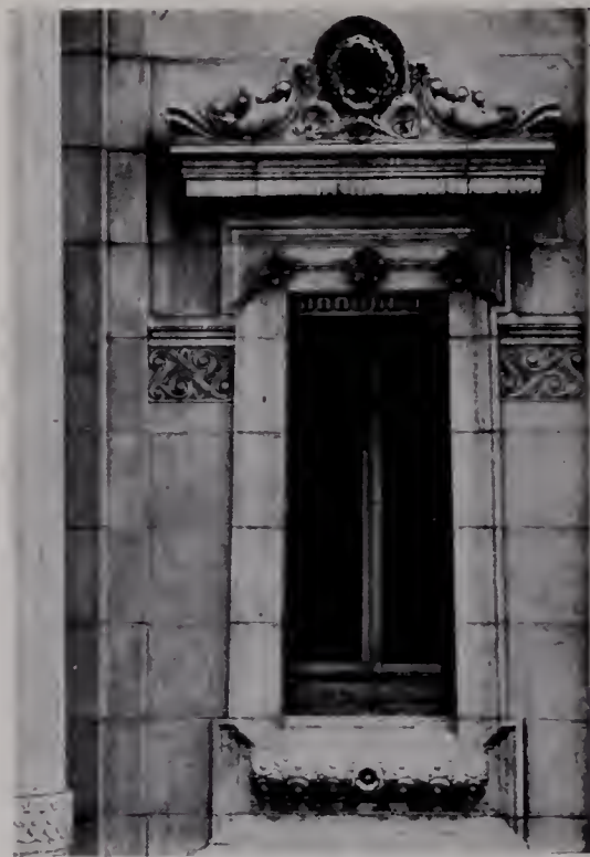
103. Finestra dei muri perimetrali
