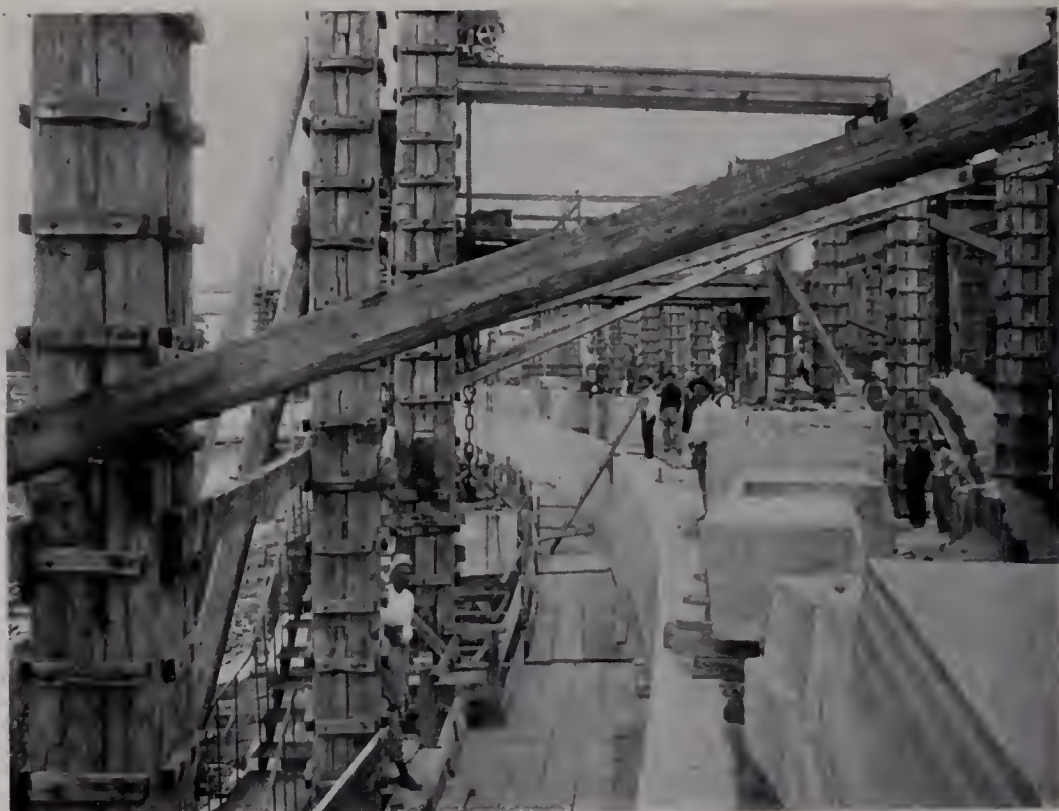
231. — Mentre fervono i lavori
