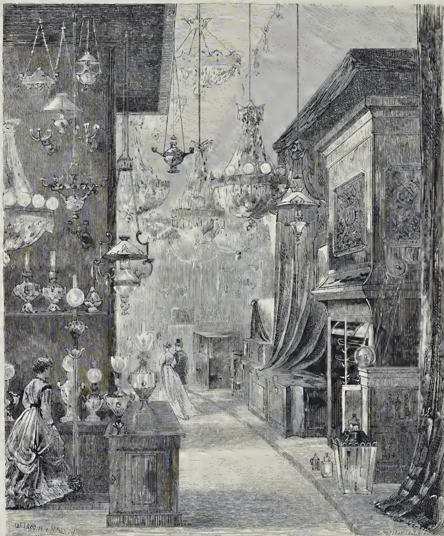
EXPOSITION DES APPAREILS DE CHAUFFAGE ET D'ÉCLAIRAGE. — Dessin de M. Desroches-Valnay.
