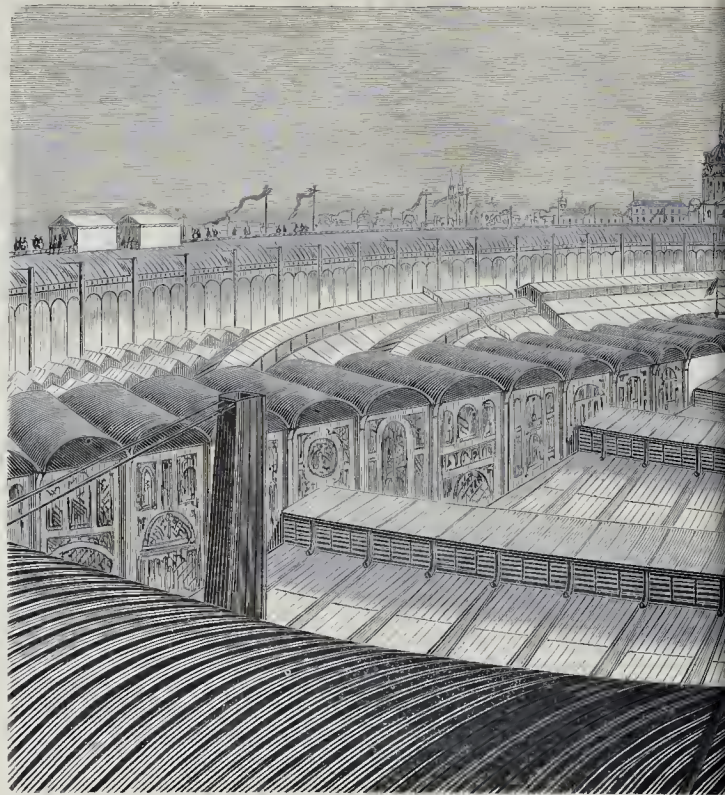
VUE PRISE SUR LA PLATE-FORME DU
