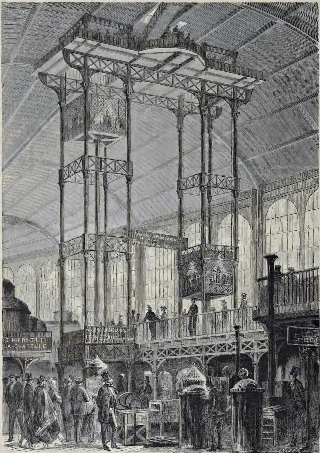
LES ASCENSEURS MECANIQUE DE M. LÉON EDoux. -- Dessin de M. Lauson.
