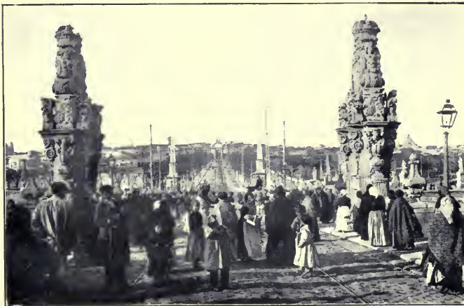
Fig. 90.—Madrid. Puente de Toledo. (See p. 188.)
