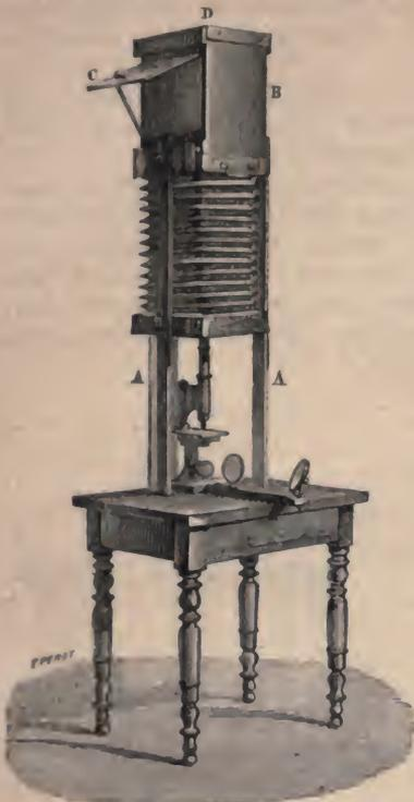
Fig. 42. Moitassier's Appar. *A* Säulen der Balgcamera *B*; *C* deren Klappe; *D* Rahmen.
