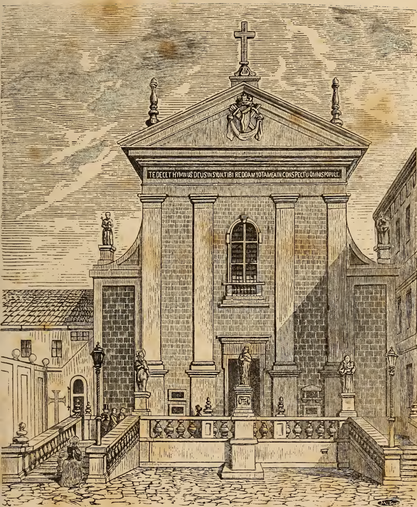
KOŚCIÓŁ PRZEMIENIENIA PAŃSKIEGO OO. KAPUCYNÓW. przy ulicy Miodowej.
