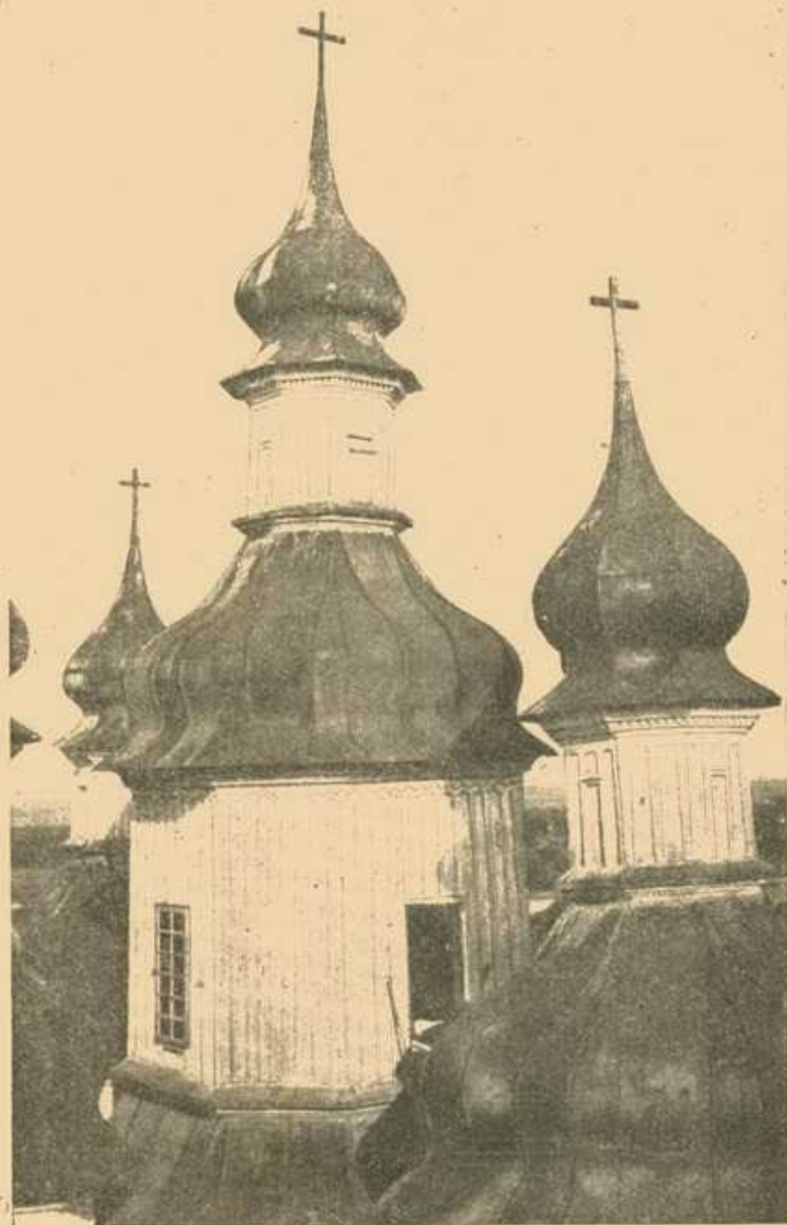
Рис. 1. Кровля куполовъ Покровской церкви.
