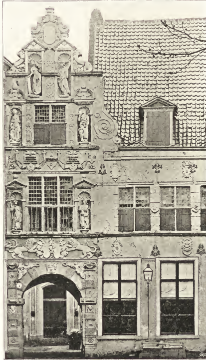
Afb. N o . 420. Nog bestaande zandsteenen woonhuisgevel uit de tweede helft der XV de eeuw te Deventer.
