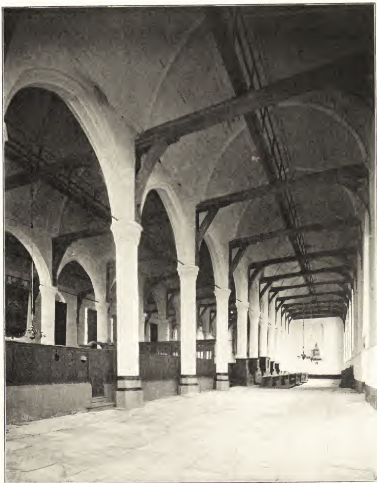
Afb. N o . 216. De in hout overwelfde Hallen-, de Sint-Nicolaaskerk te Monnikendam, naar photo.
