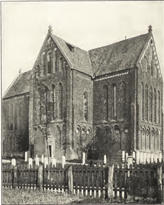
Afb. N o . 200. De nog bestaande XIII de -eeuwse baksteenen kruiskerk te Zuidbroek (prov. Groningen), gezien van de zuidoostzijde, naar photo.
