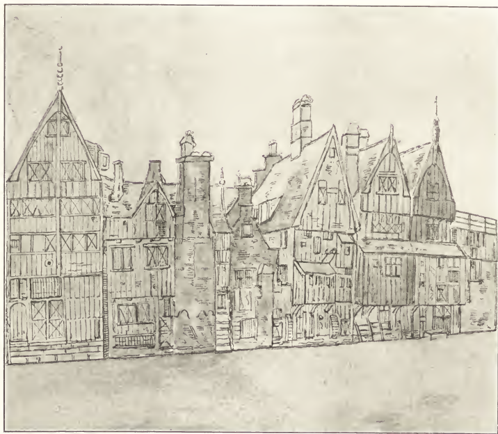
Afb. N o . 398. Houten achtergevels van eenige huizen staande aan eene gracht te Amsterdam, naar eene oude teekening.
