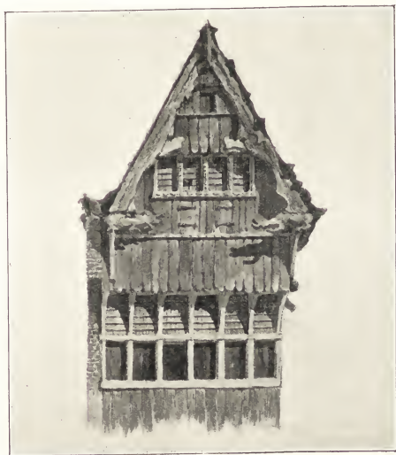
Afb. N o . 427. 's Hertogenbosch. Een der 't laatst overgeblevene houten huizen aldaar naar A. Oltmans, A o . 1835.
