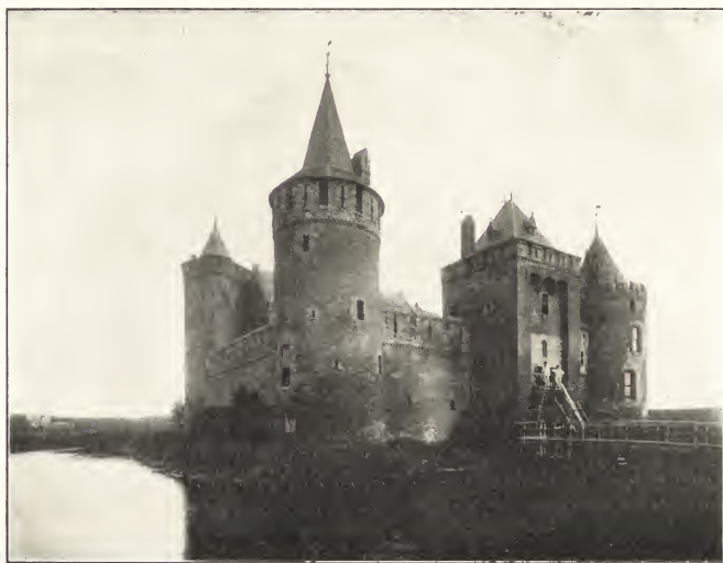
Afb. N o . 289. Het Kasteel te Muiden, naar photo.
