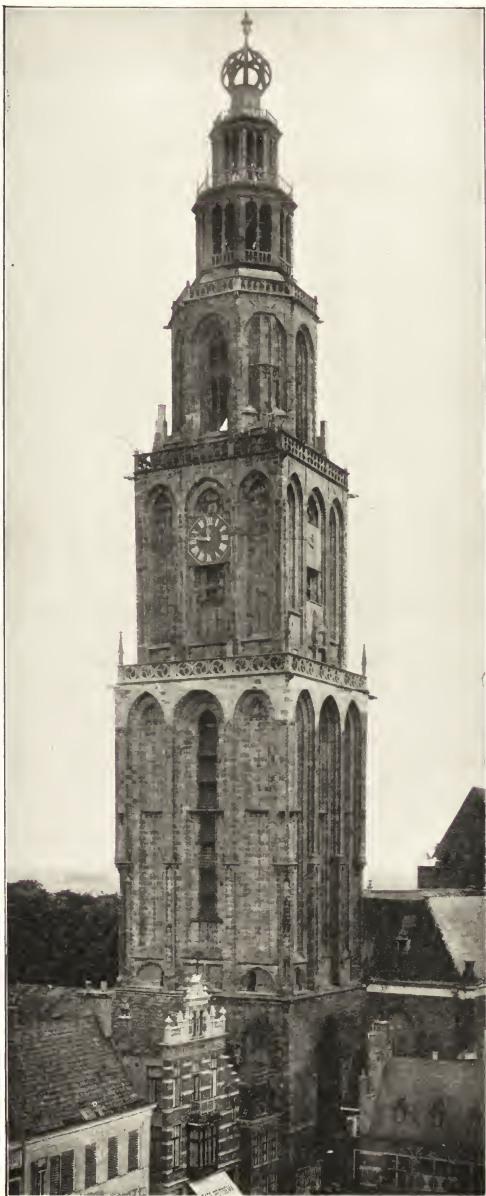
Afb. N o . 243. De Sint-Martinitoren te Groningen, gebouwd in de jaren 1369—'82, naar photo.
