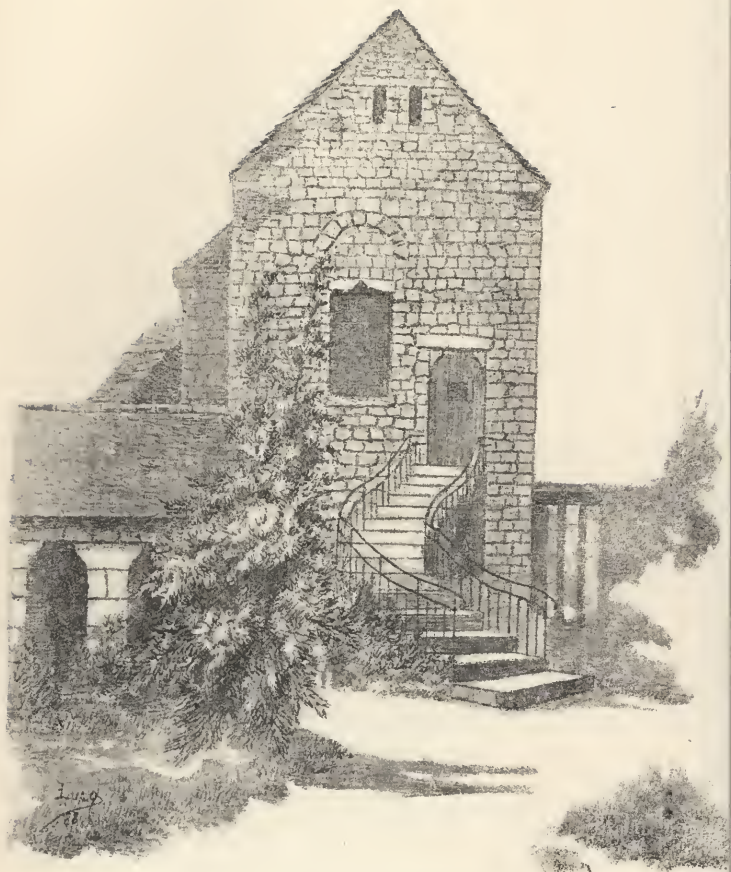
C. — ENTRÉE DE LA CHAPELLE
