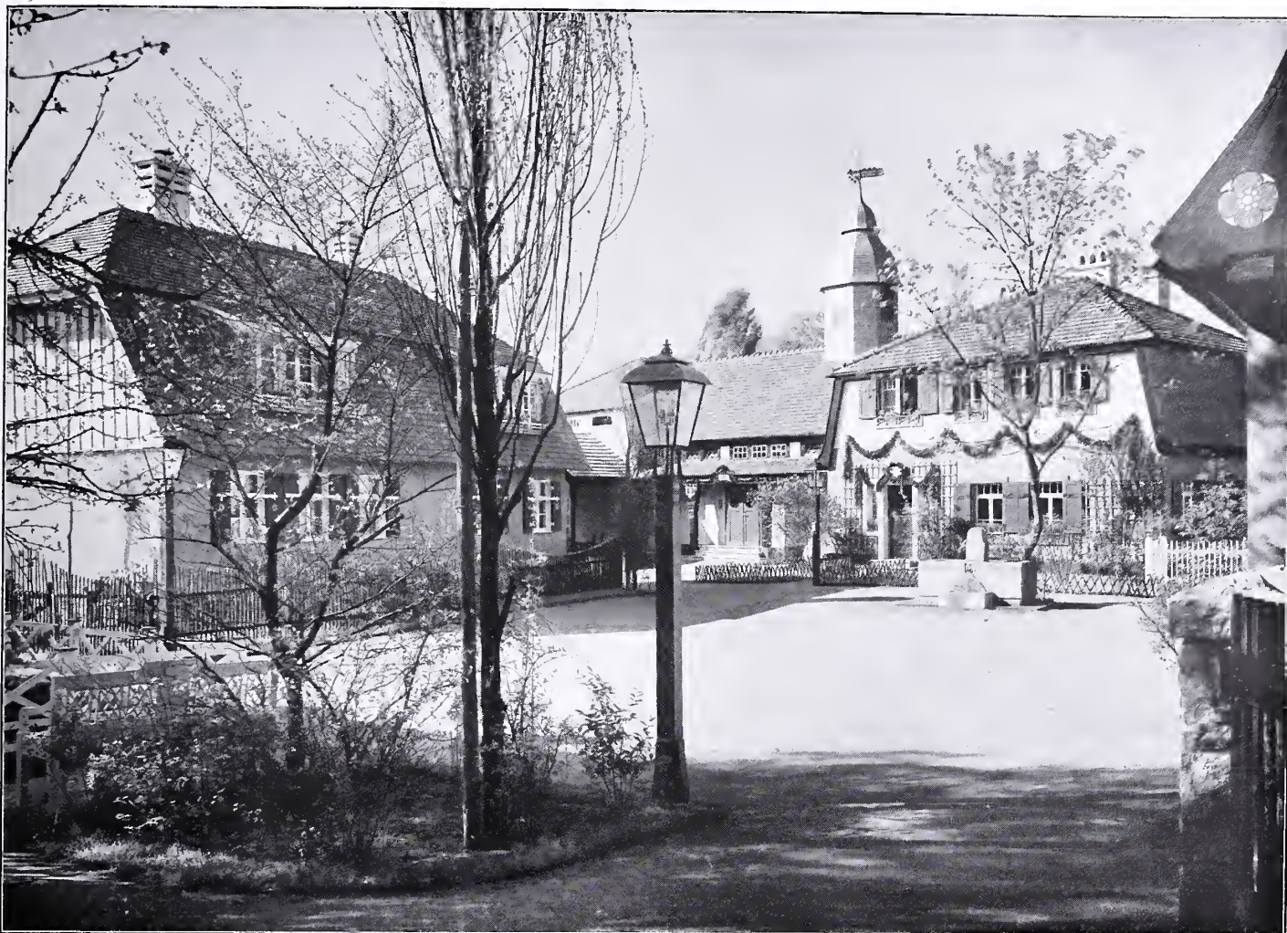
Links: Ein- und Zweifamilien-Arbeiterhaus mit erzgebirgischem Vorgarten und Zubehör, erbaut vom Amtshauptmann von Nostitz Drzewiecki-Pirna. Entwurf und Bauleitung vom Architekten Richard Bauer-Leipzig (Verwendung heimischer Baustoffe im Sinne bodenständiger Bauweise ohne Architekturformen — sparsame Bauweise — zusammenhängende geschützt liegende Wandflächen)
