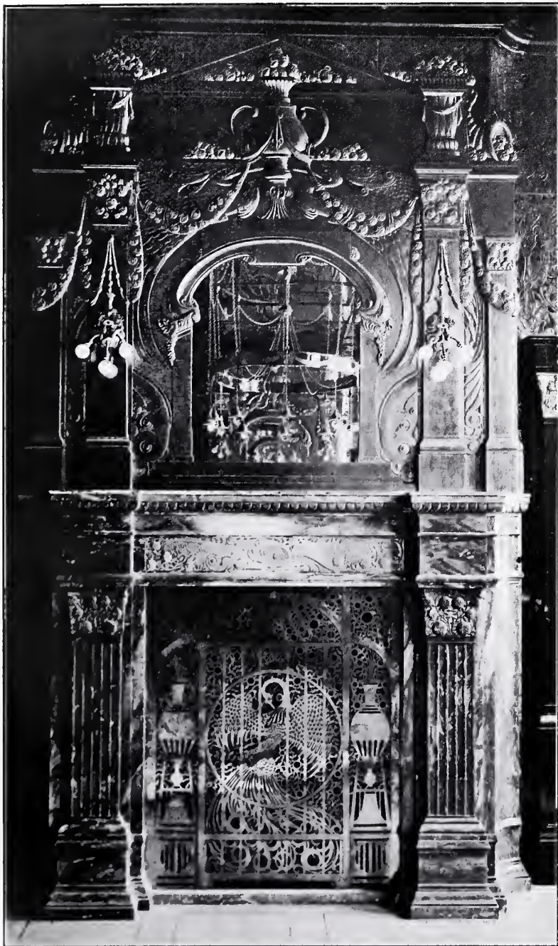
GÜLDENKAMMER IM RATHAUS ZU BREMEN, EINGERICHTET VON HEINRICH VOGELER. HEIZKÖRPERVERKLEIDUNG AUS SIENESER MARMOR MIT VERGOLDETEM HOLZGESCHNITZTEM AUFSATZ. HEIZUNGSGITTER AUS MESSING
