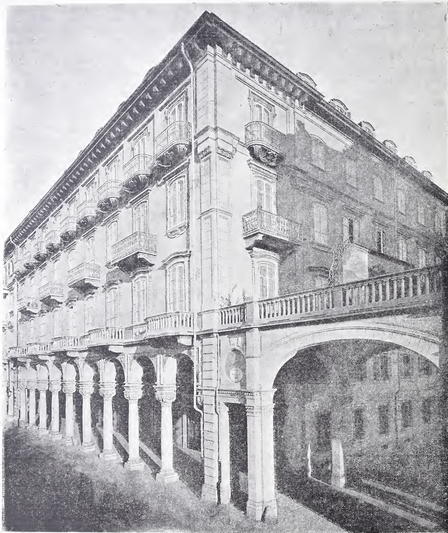
Maison Besozzi, à Turin. — Architecte : M. C. Riccio.
