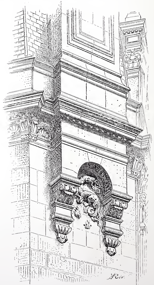
Souche de cheminée d'angle.
