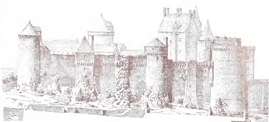
FAÇADE DV COTÉ SVD-OVEST
