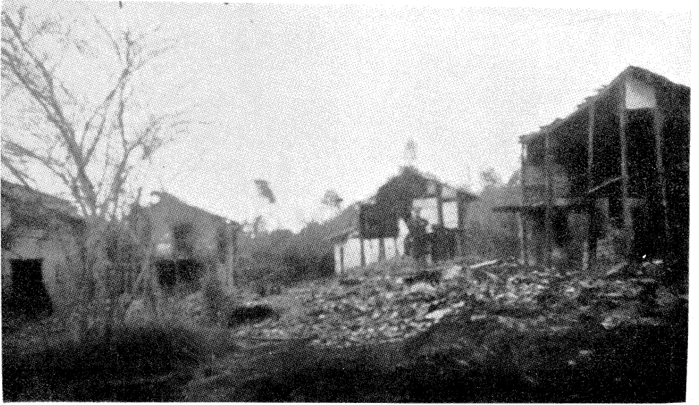
屋 村 之 燒 所 匪 被 城 南 於 近
