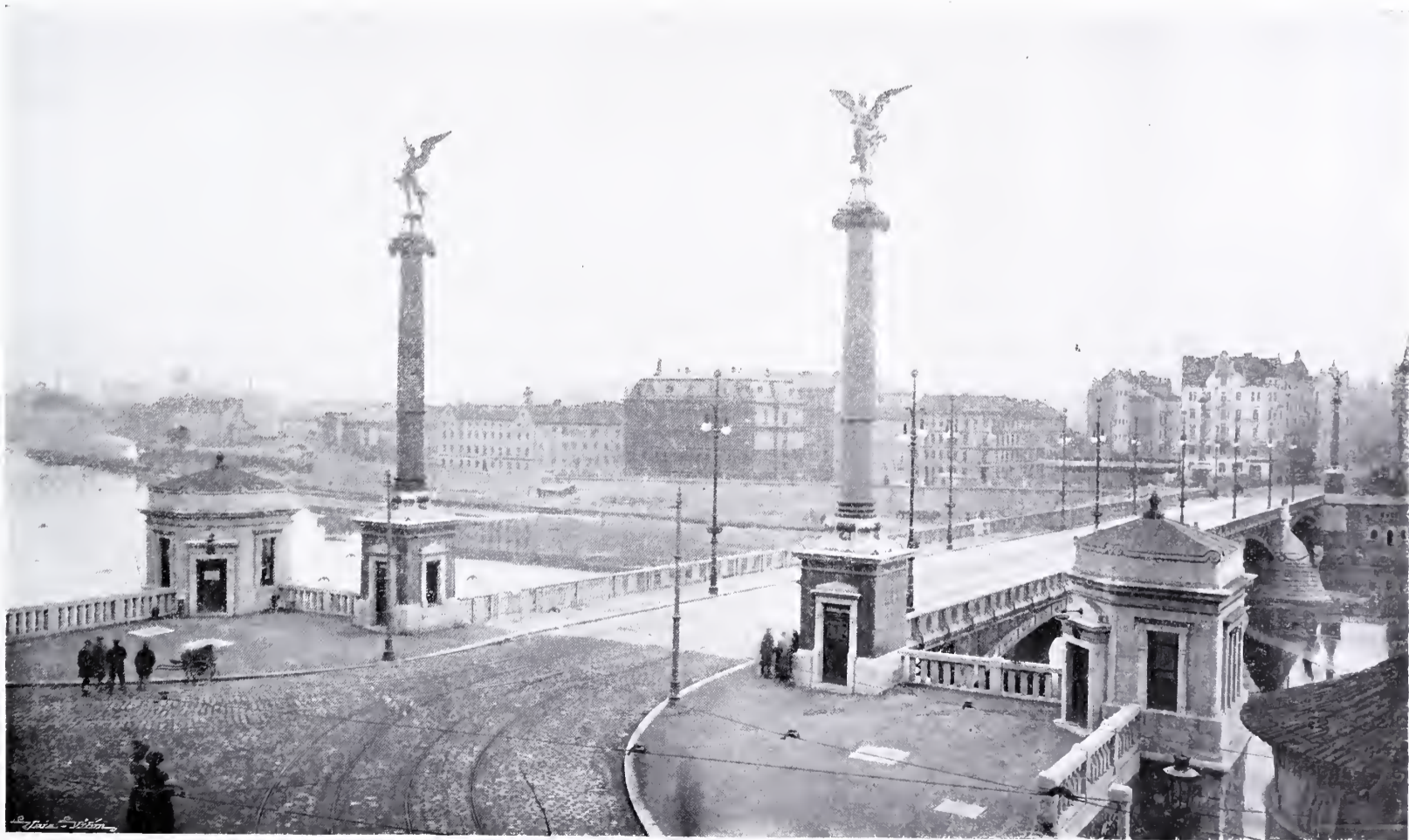
Čechův most v Praze. — Pohled na předmostí pod Letnou. Architektonické řešení prof. J. Kouly.
