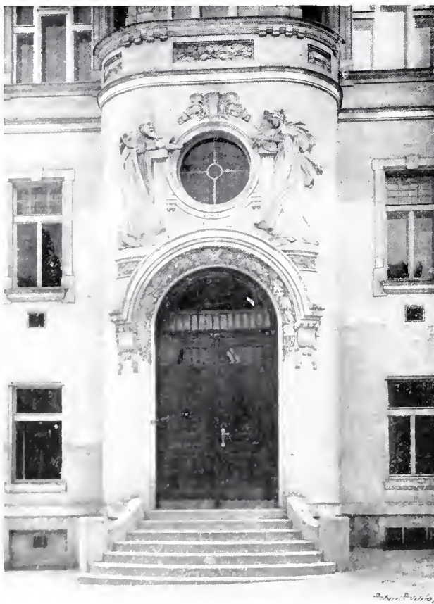
Klárova ústav slepců v Praze-III. — Hlavní vchod. Arch. dr. J. Pískač. — Sochař Ant. Štrunc.
