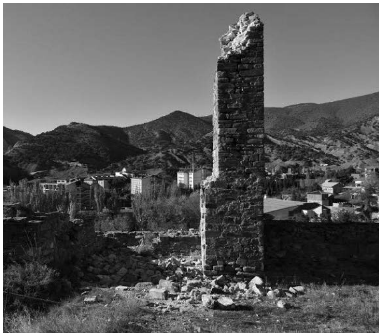
Частина давньої вежі у Судацькій фортеці, що впала у листопаді 2015 року внаслідок розпочатого на території музею будівництва
