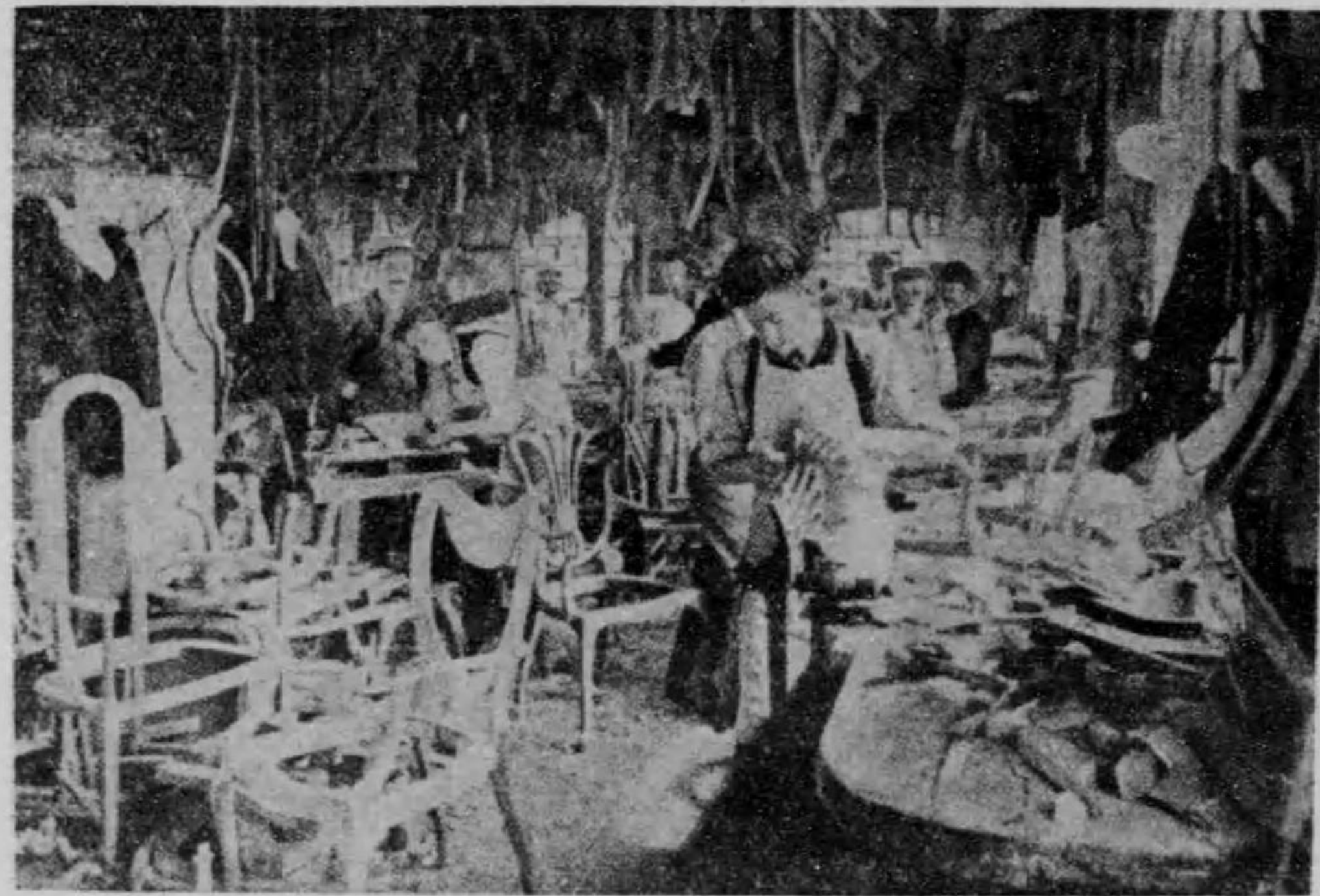
第三十八圖 椅子の骨組方
