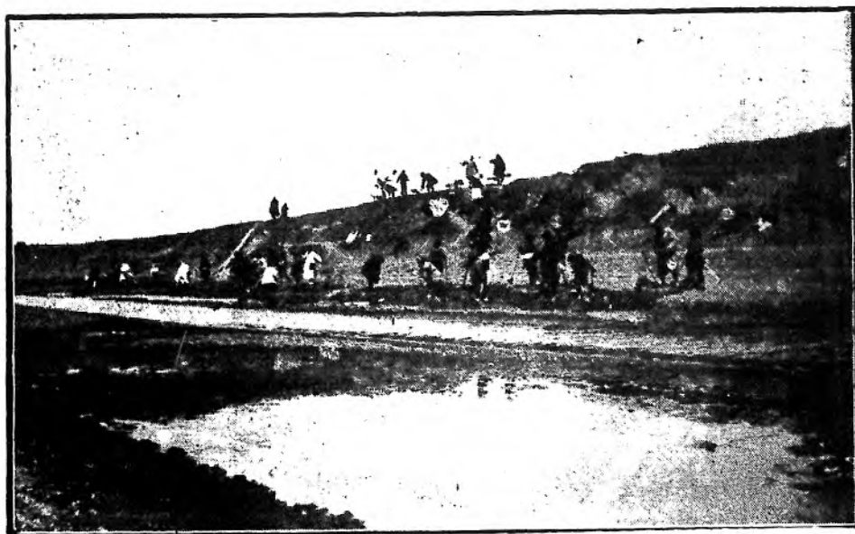
(廿二) 江浦縣修復圩 堤工作狀況攝影
