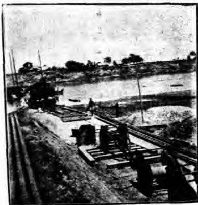
用絞重機絞機車上岸
