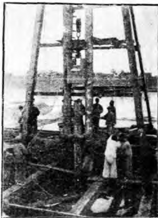
末河橋工打樁進行 (廿三，十一，初旬攝)
