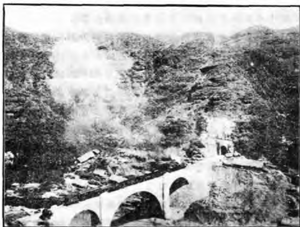
省界拱橋隧道
