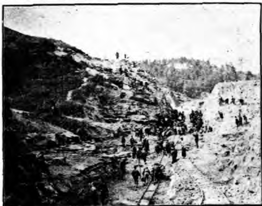
確嶺冲北口石工情形
