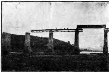
深河架梁次序之六(俟框拖出後用千斤頂將鐵梁放落)
