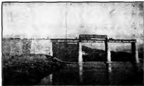
深河架梁次序之五(鐵梁由平車推置於吊車上)
