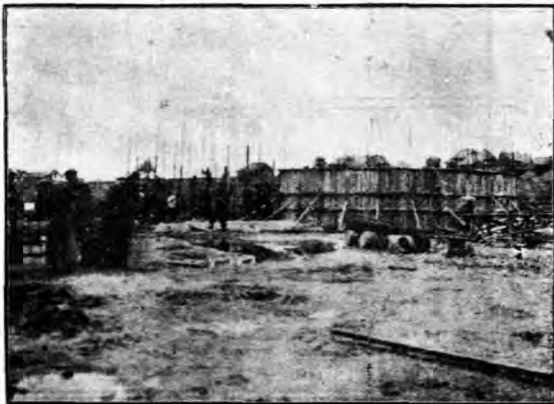
未河橋墩沉箱工作
