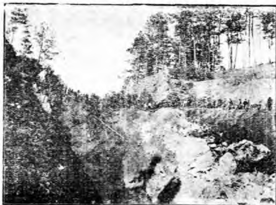
白面石隧道開挖工作之一
