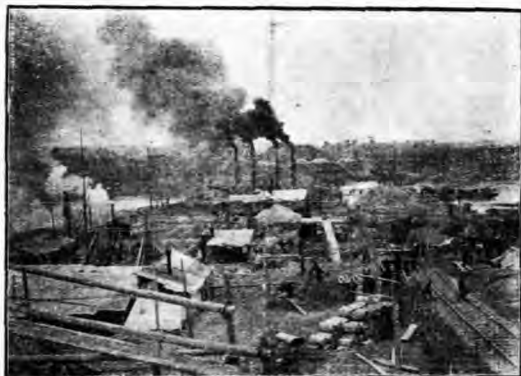
涿河橋工全景
