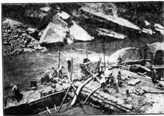
北橋墩用抽水機抽水
