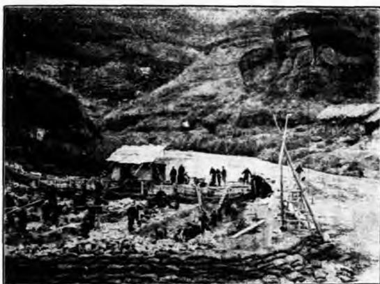
省界大橋墩拱架基礎
