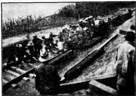
涿河架梁次序之一 由便線施運梁鋼件至橋梁處)
