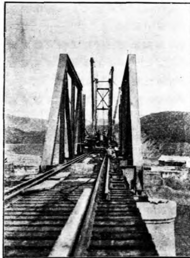
珠河四十五公尺桁架用起重機搬運架設情形
