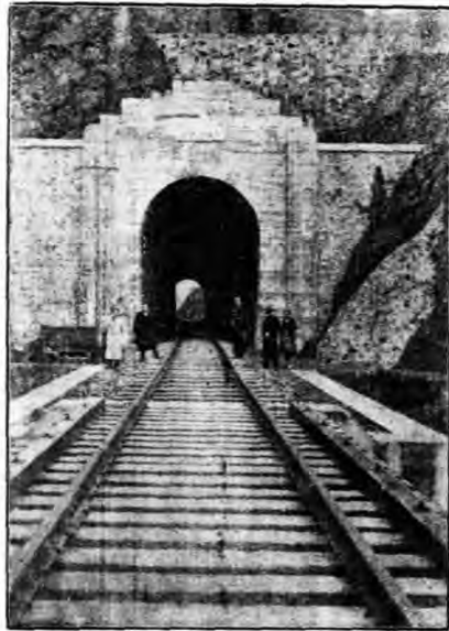
已完成之大沿水隧道
