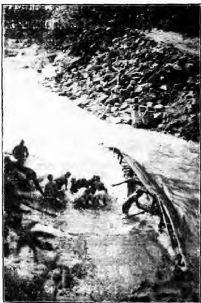
最險灘頭運洋灰船之翻覆工人於水中搶救情形
