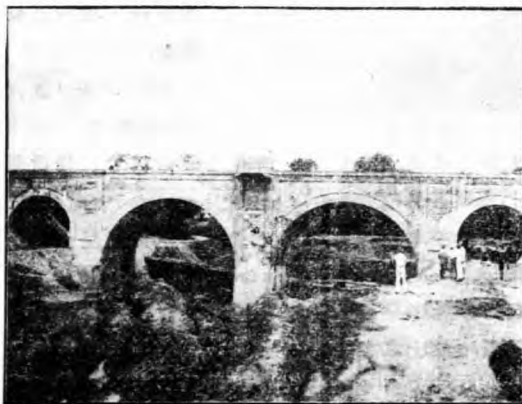
七橋三分段鋼筋混凝土橋 (十公尺者二孔五公尺者二孔)
