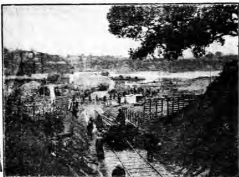
漾河橋工運送材料情形
