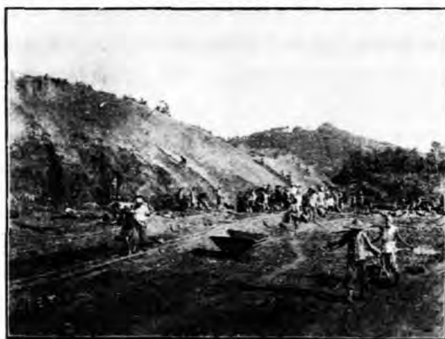
本路三總段土方工程之二
