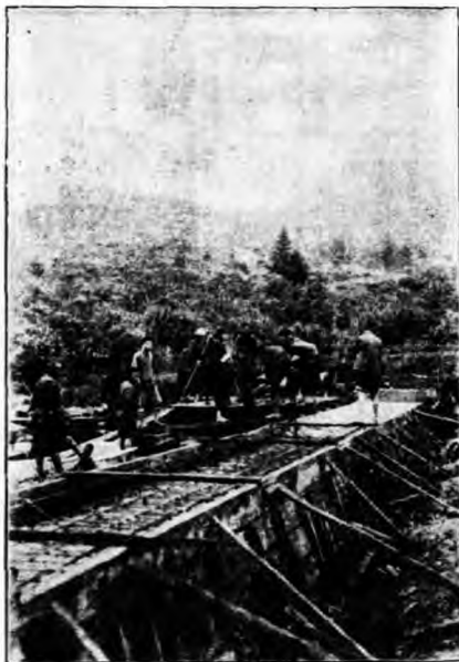
四萬餘公里六八一加七零零箱渠之建築。
