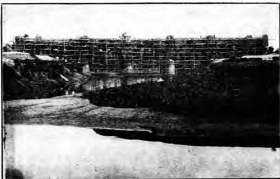
石澗河五孔十五公尺拱橋竣工全景
