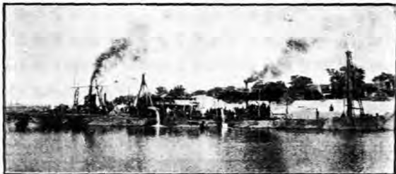
濠河橋工八號橋墩機器抽水情形
