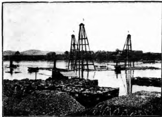
未河橋工各墩打樁攝影
