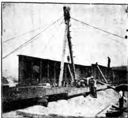
涿河架梁次序之二，用足重樁架台鋼梁)
