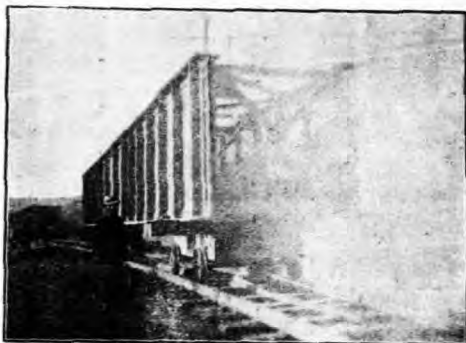
涿河架梁次序之三(將已辦好之鐵梁托於特製平車上)
