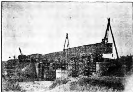
五總段界牌橋架設鋼梁之又一法
