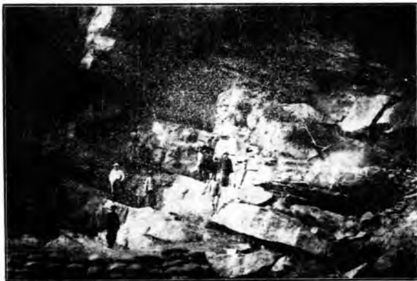
南橋墩基礎挖竣之石層情況
