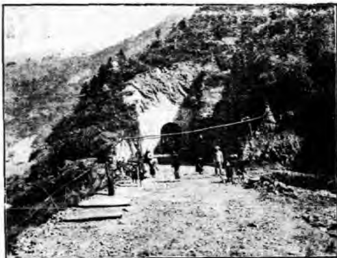
岐門隧道完成之景
