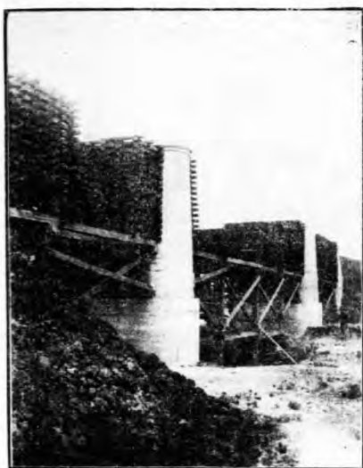
韶陵河橋預備架橋
