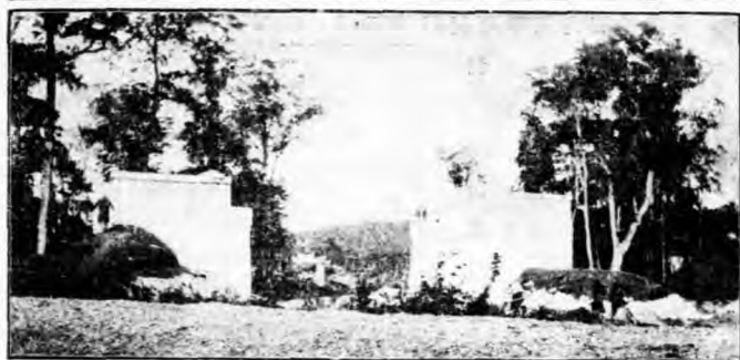
粵永公路交叉處鐵路跨橋橋樑修成之攝影
