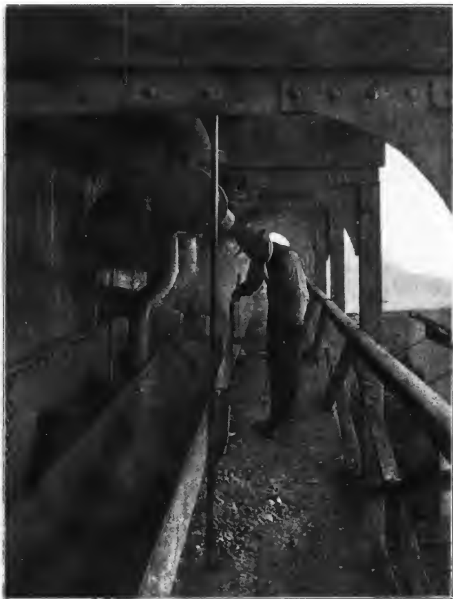
FIG. 14.—Machinery In the Oficina.
