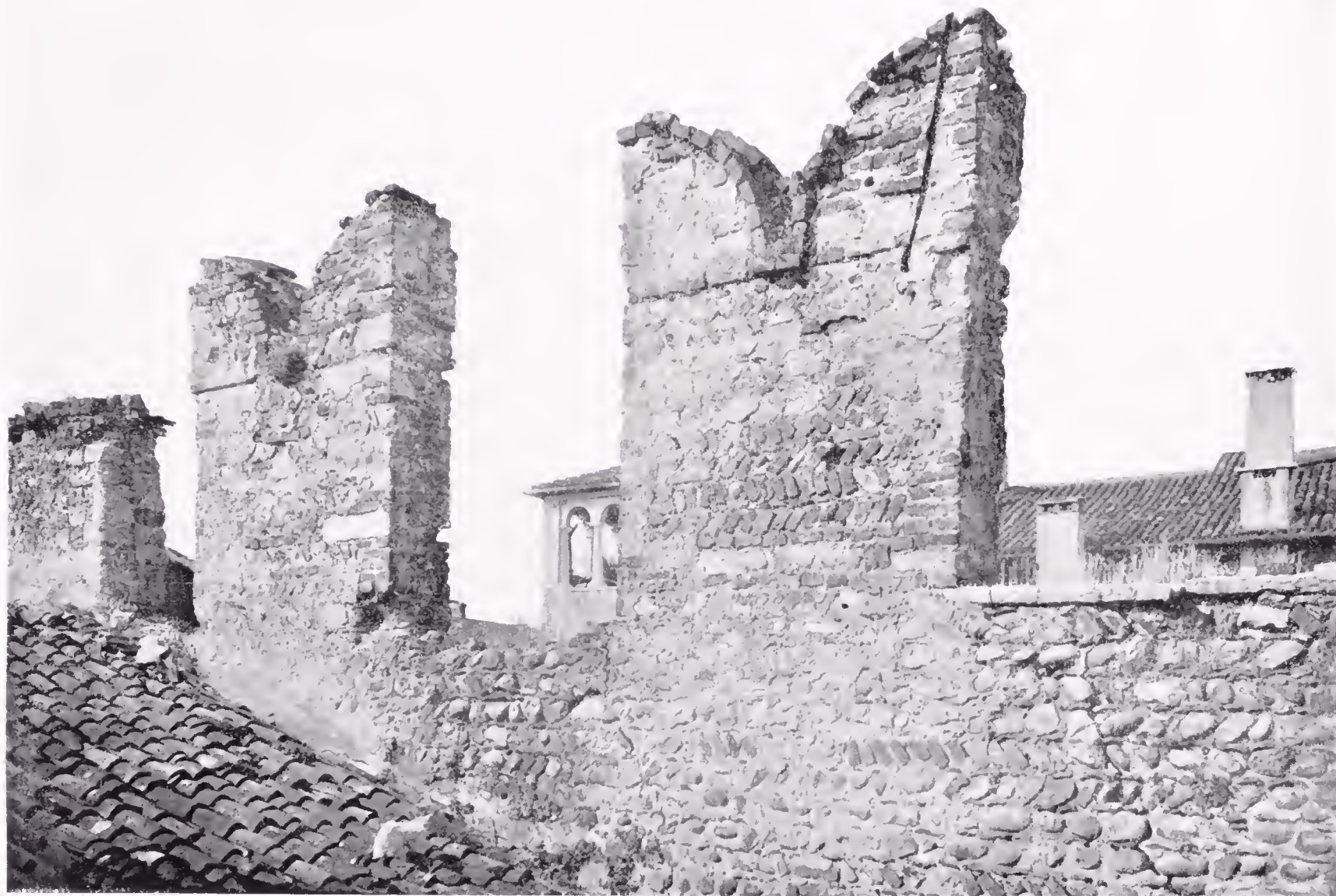
MERLATURA DELLA CASA DI GIULIETTA IN VIA CAPPELLO.
