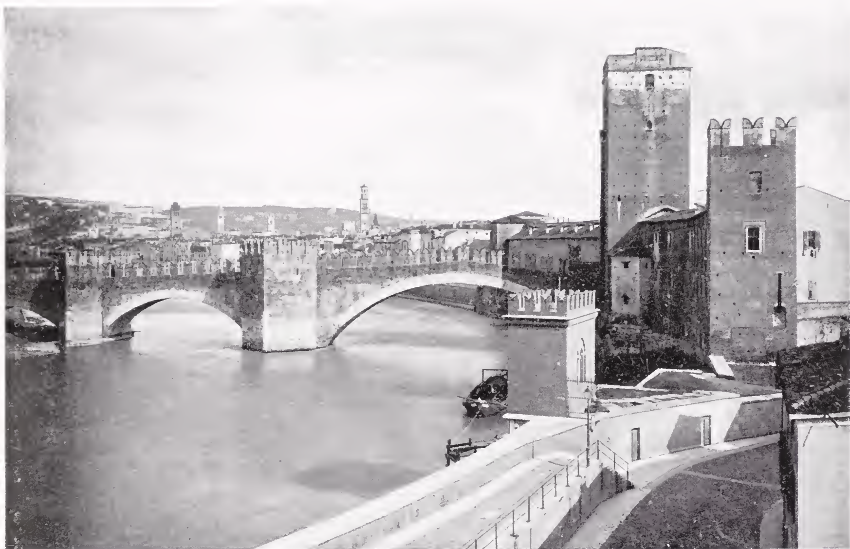
PONTE DI CASTELVECCHIO SULL'ADIGE.
