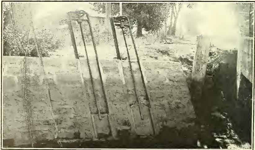
FIG. 3.—DELIVERY GATES ON NORTH POUDBRE CANAL, COLORADO.
