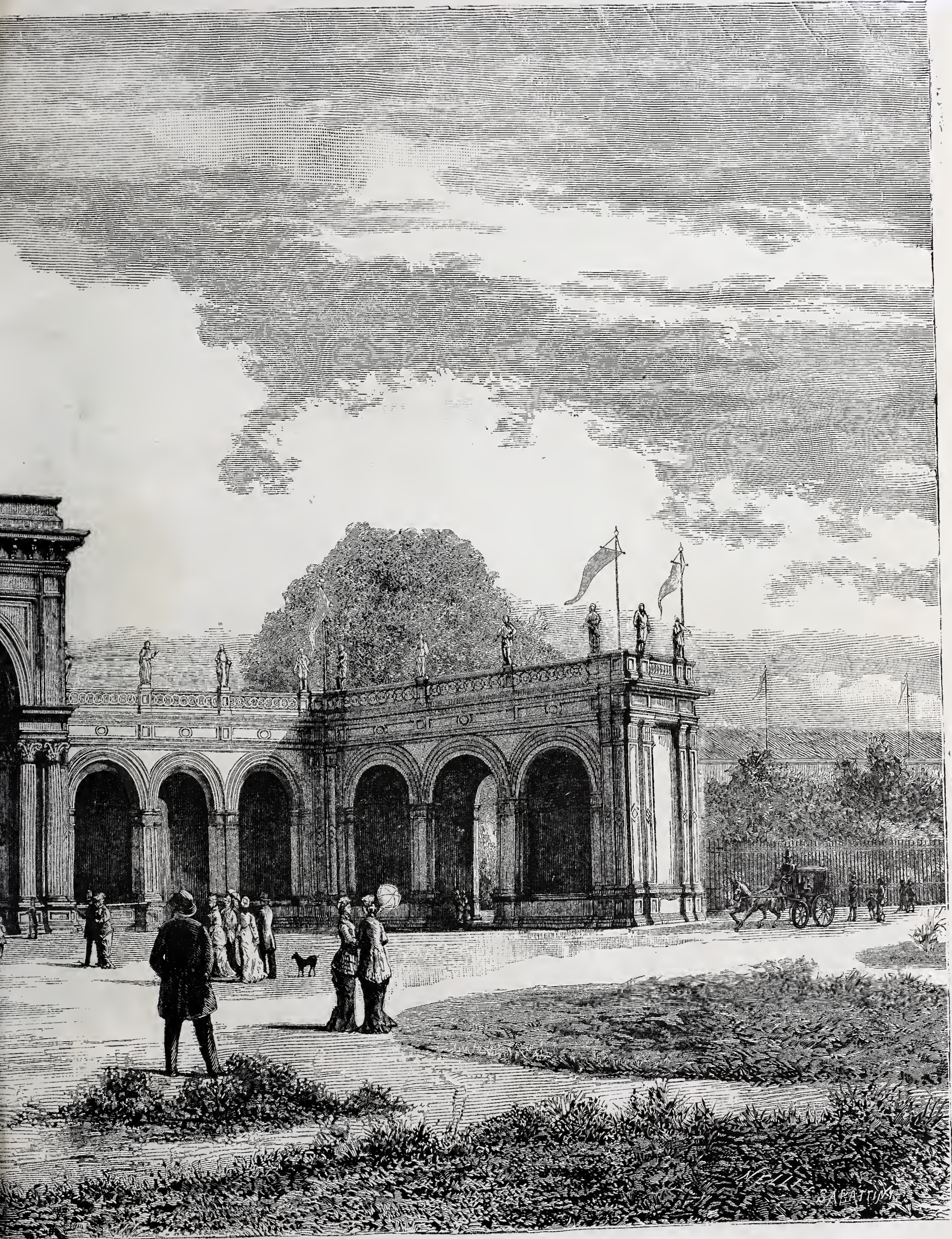
Via Palestro (altezza dell'arco centrale metri 22, dell'atrio metri 12 ; lunghezza metri 81).
