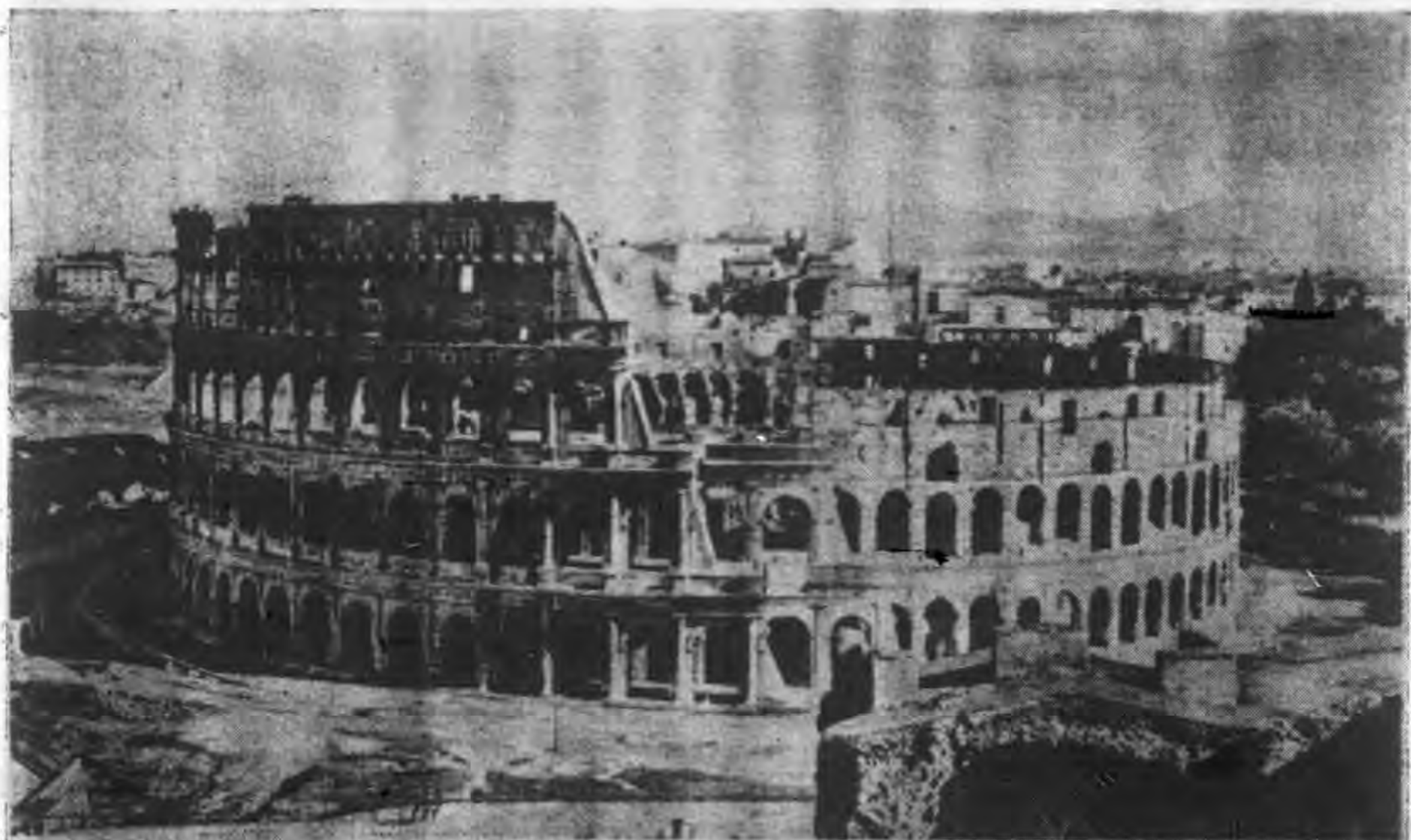
LE COLISEE ( Colosseo ). L'amphithéâtre, construit par Vespasien et Titus (80 apr. J.-C.) sur l'emplacement des jardins de Néron, pouvait contenir de 40 000 à 50 000 spectateurs. Axes : 188 et 156 mètres; axes de l'arène : 78 m ,75 et 53 m ,62; haut. : 48 m ,50. Forteresse au Moyen Age, il a fourni, du xv e au xvii e siècle, des matériaux pour la construction de nombreux palais romains, entre autres le palais Farnèse. — G. ANDERSON.
