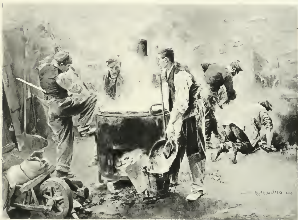
CARRIER-BELLEUSE (L.). Une équipe de bitumiers à Paris.
