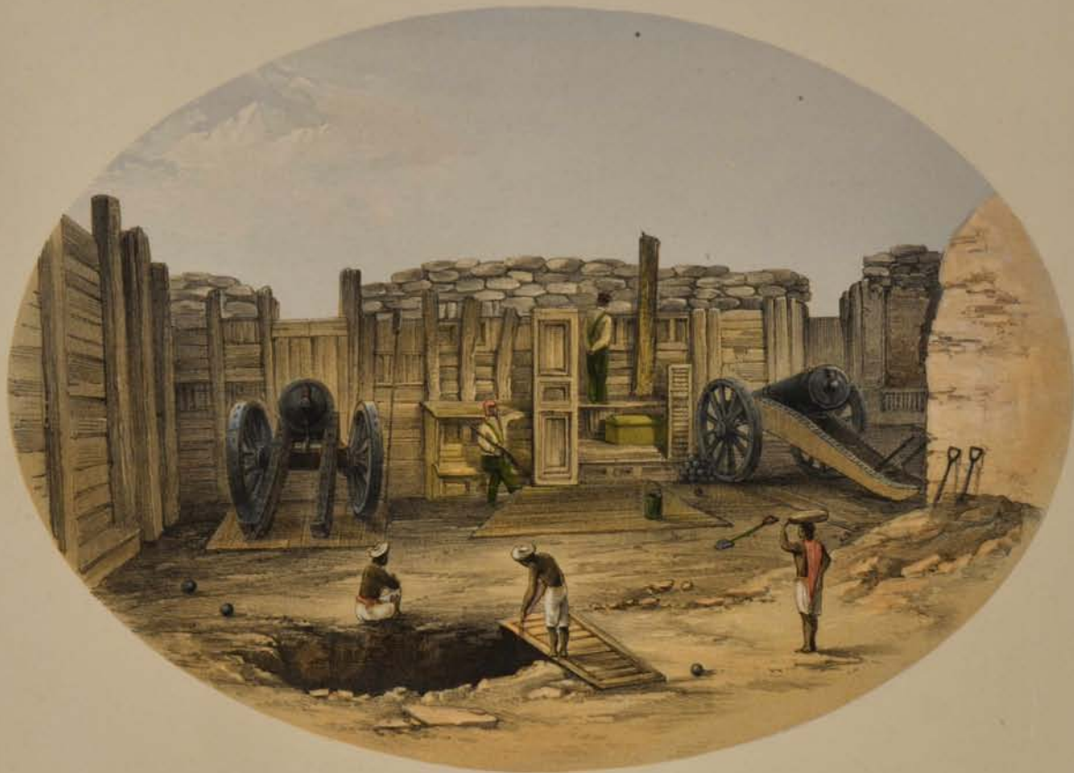
Nº 10. THE NEW CAWNPORE BATTERY
