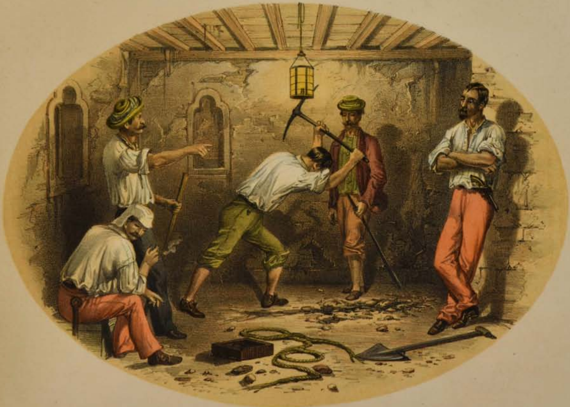
Nº 27. SINKING A SHAFT.
