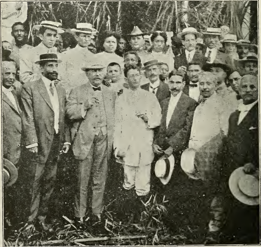
El General José Miguel Gómez y acompañantes en el acto de la inauguración de las obras del Roque President Gomez and members of his cabinet at the inauguration of the work of digging the Rogue canal, August, 1911.
