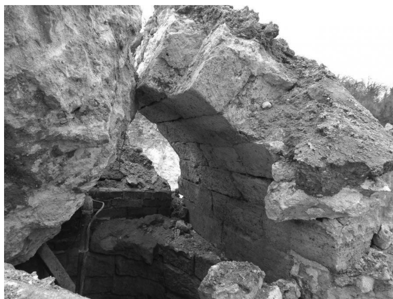
Знайдений під час робіт на об'єкті культурної спадщини «Форт Меншиков» унікальний кам'яний колодязь з арковою конструкцією, м. Севастополь, 2019 р.
