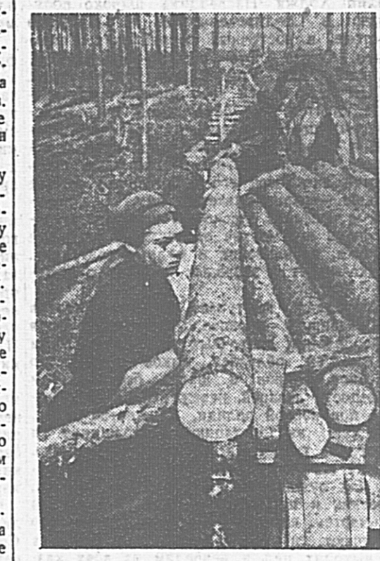
В Мошковском лесхозе (Новосибирская область) проведена круглогодичная дорога, которая ускоряет вывозку древесины в 4—5 раз. Она проста по своему устройству и легко переносится с участка на участок. На снимке: колхозники сельхозартели «Общий труд» М. БУСАРОВА и В. ГРИШКИНА на портужке леса.
