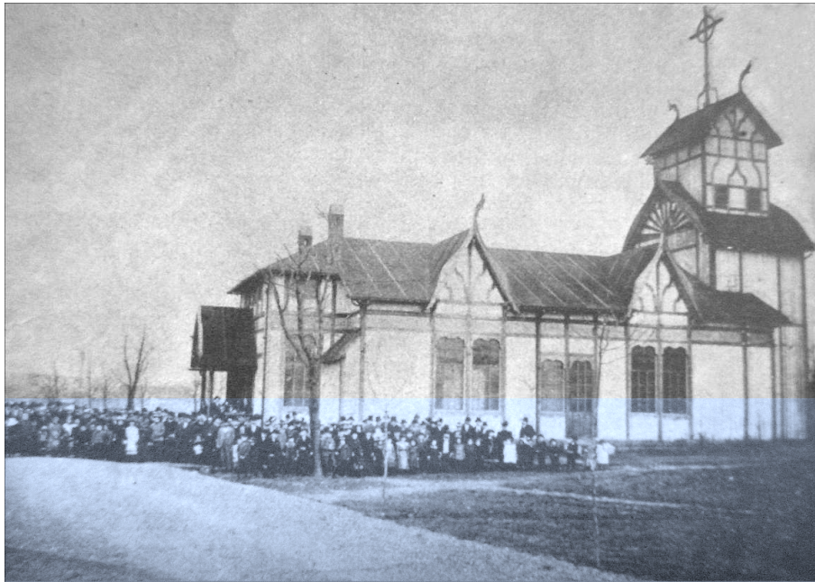
Interimskirche in Fachwerk- Bauweise 1899
