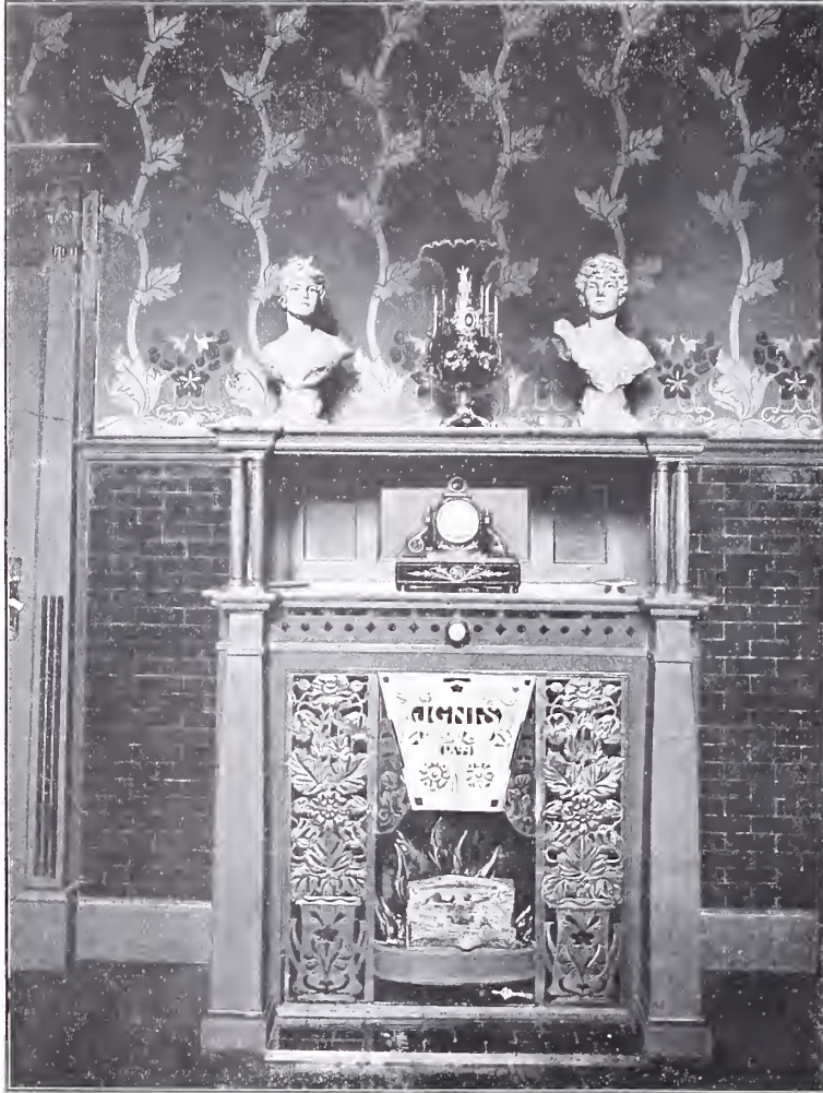
Villa Spindler zu Spindlersfelde. Kamin als Heizkörper-Verkleidung. Von SCHULZ & SCHLICHTING, Architekten in Berlin.
