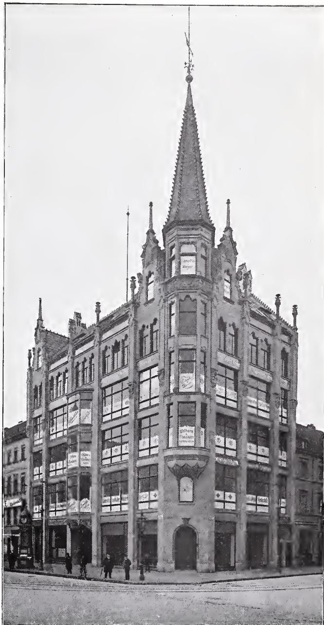
Kaufhaus Kaiser Wilhelmstrasse 27 in Berlin. Von TRAUOGOTT KRAHN, Architekt in Wilmersdorf.
