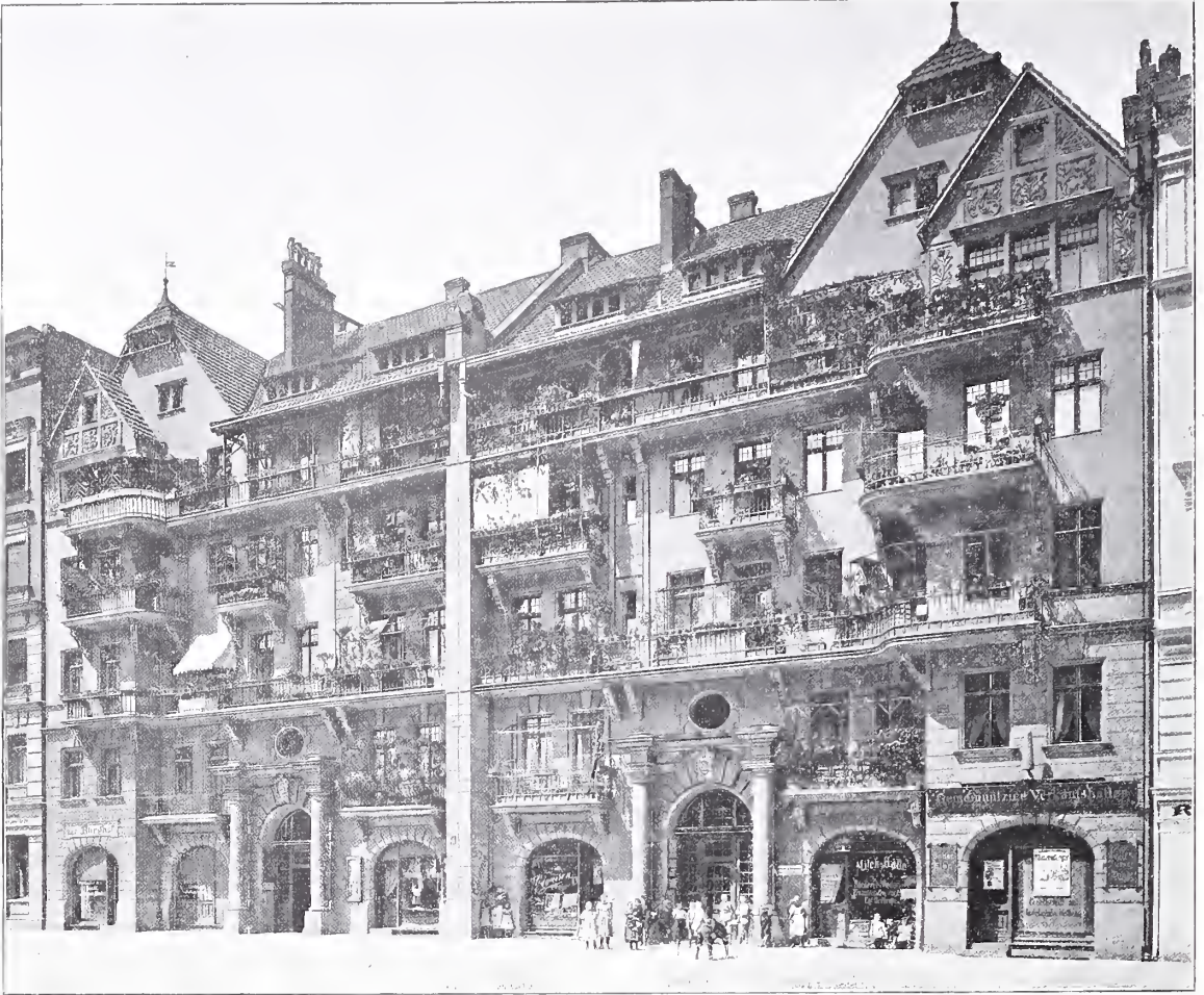
Arbeitermiethäuser Sickingenstrasse 7 u. 8, erbaut nach dem Entwurfe von ALFRED MESSEL in Berlin.
