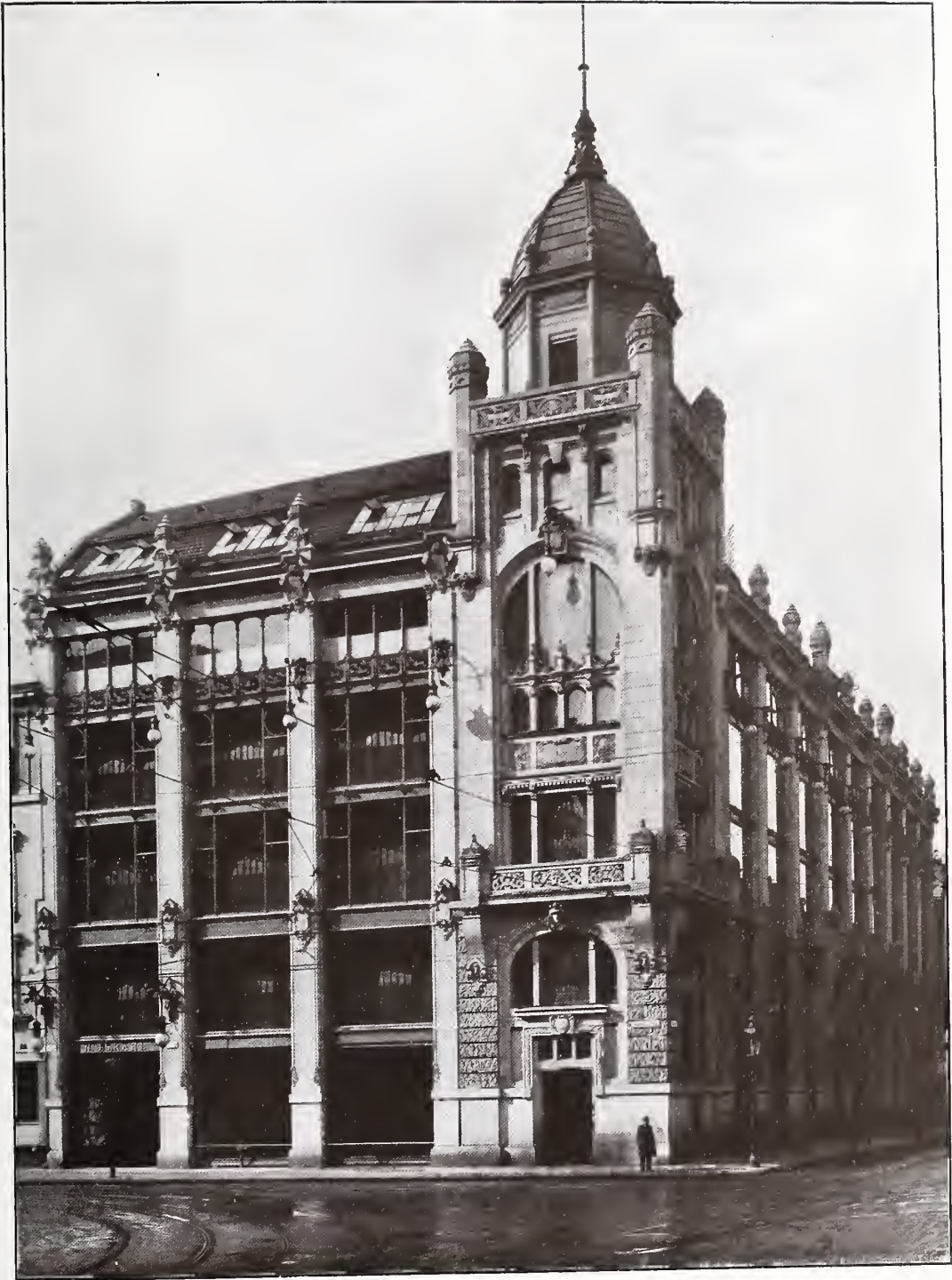
Kaufhaus N. Israel, Ecke Spandauer- und Königsstrasse. Erbaut von LUDWIG ENGEL in Berlin.
