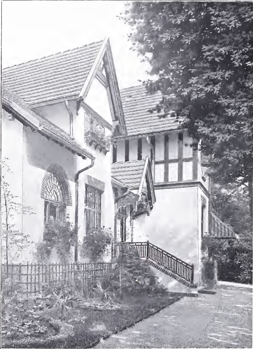
Cavalierhaus in Kerzendorf. Erbaut von KARL HOFFACKER, Architekt in Charlottenburg.
