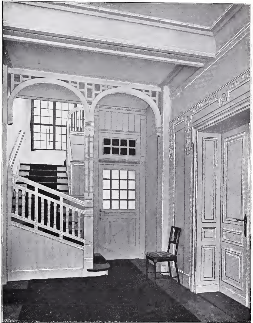
Diele im Cavalierhaus Kerzendorf. Von KARL HOFFACKER, Architekt in Charlottenburg.
