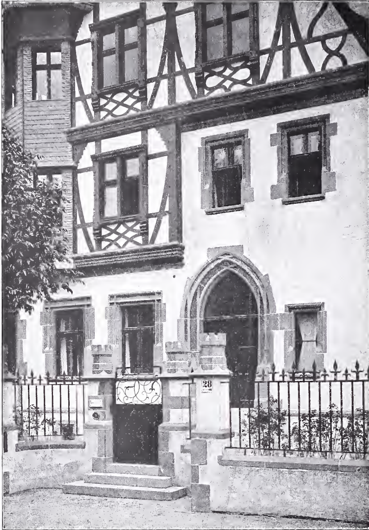
Villenkolonie Grunewald, Villa Hartung, Beyeinstrasse 28—30. HUGO HARTUNG, Architekt, V.-K. Grunewald. Haupteingang und Façadendetail.
