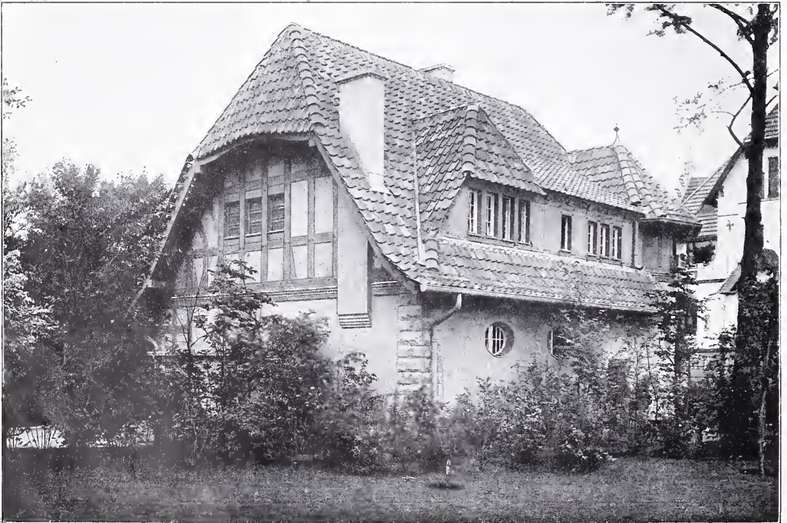
Abb. 347 u. 348 Villa Dotti, Villenkolonie Grunewald, Winklerstrasse 18. Pförtnerhaus. ALFRED MESSEL, Architekt in Berlin.
