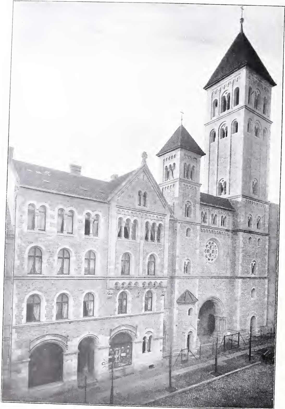
Herz Jesu-Kirche und Pfarrhaus. Fassade nach der Fehrbellinerstrasse. Architekt CHR. HEHL, Charlottenburg.
