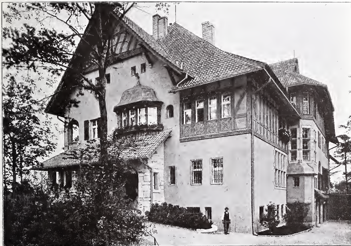
Villa Dotti, Villenkolonie Grunewald, Winklerstrasse 18. ALFRED MESSEL, Architekt in Berlin.
