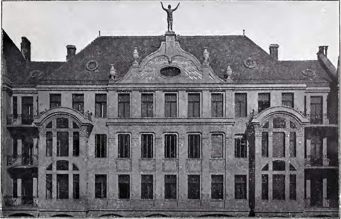
Wohnhaus Gitschinerstrasse, Ecke Alexandrinenstrasse. Architekt PAUL HOPPE, Berlin. Putzbau. Baukosten 360 000 Mark.
