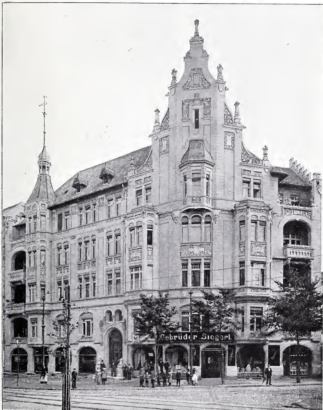
Wohnhaus in Schöneberg, Hauptstrasse 96, Ecke Maxstrasse.
