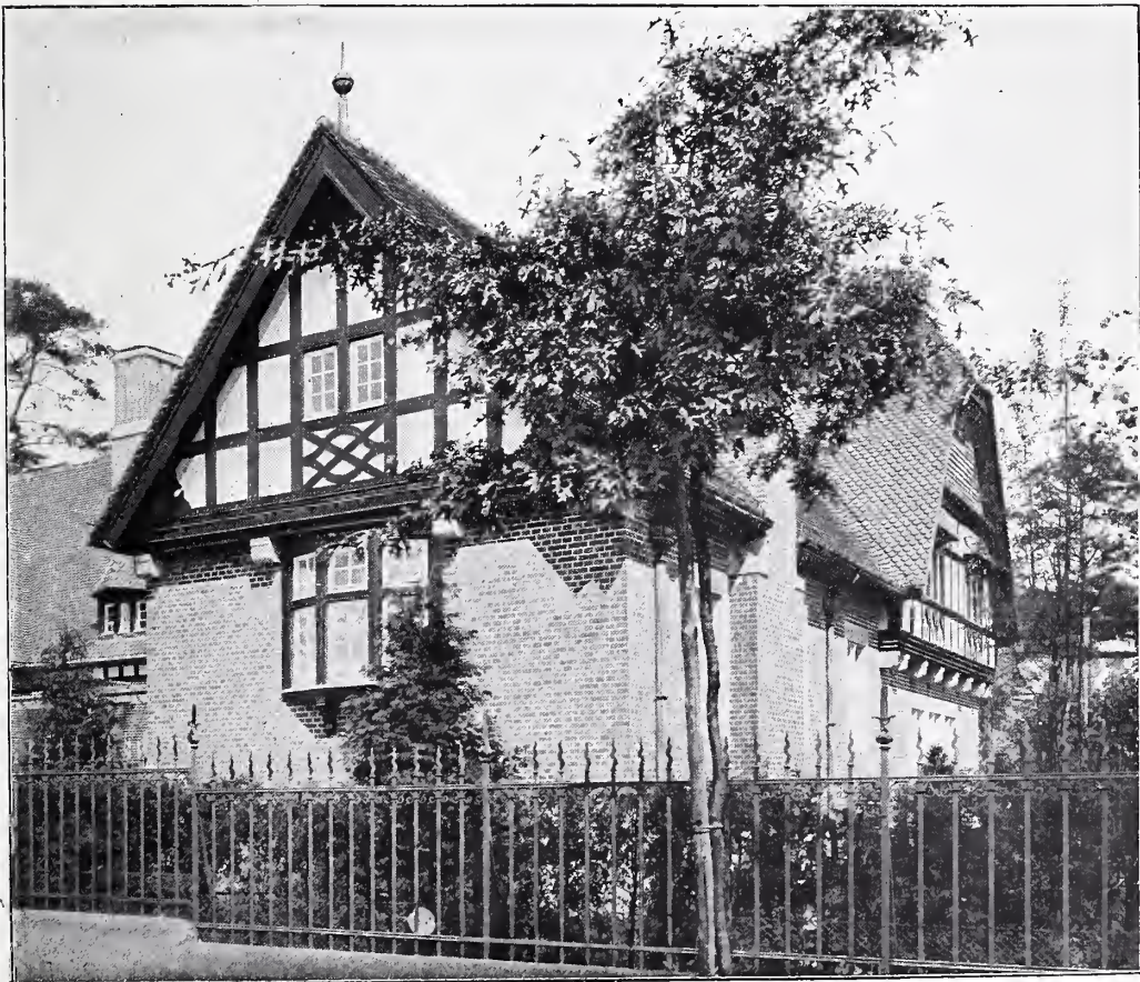
Abb. 269/270. Stallgebäude der Villa Mendelssohn, V.-K. Grunewald, Bismarck-Allee. Erbaut von ERNST IHNE, Architekt in Berlin.
