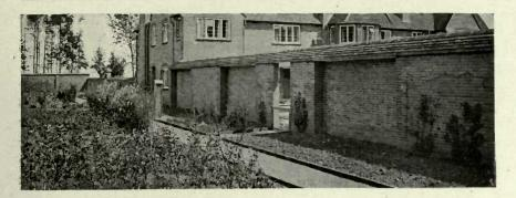
FIG. 144.—WALL WITH SQUARE BREAKS.
