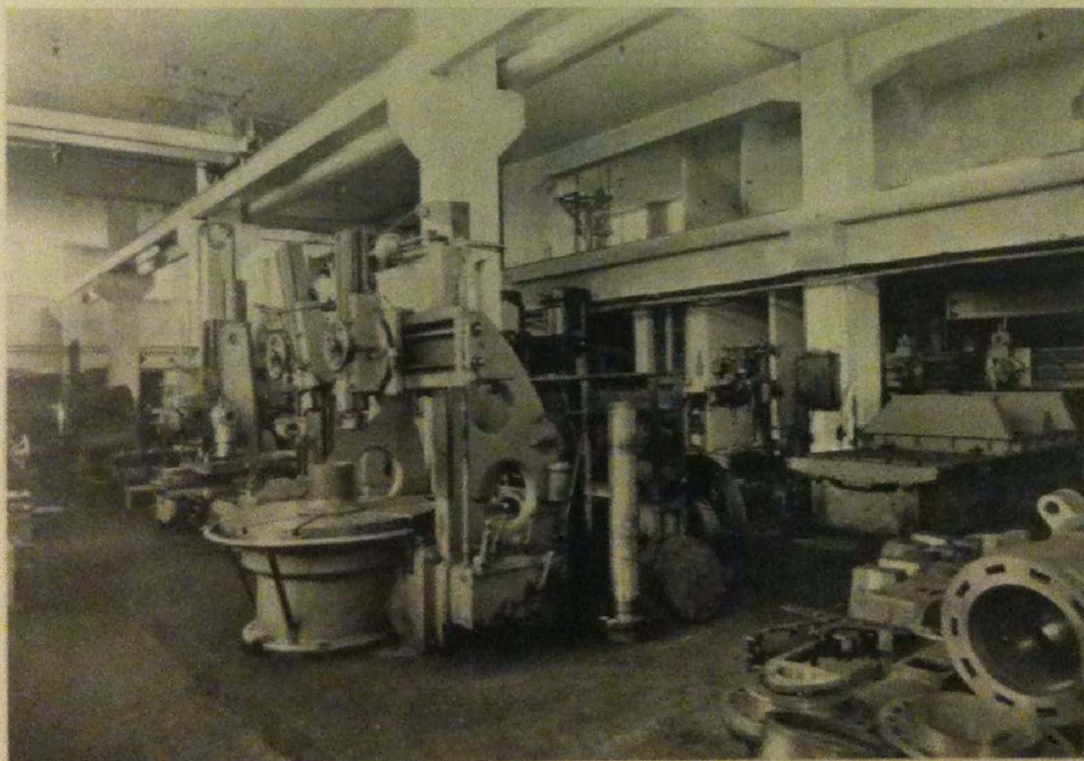
Interiør fra maskinverkstedet
