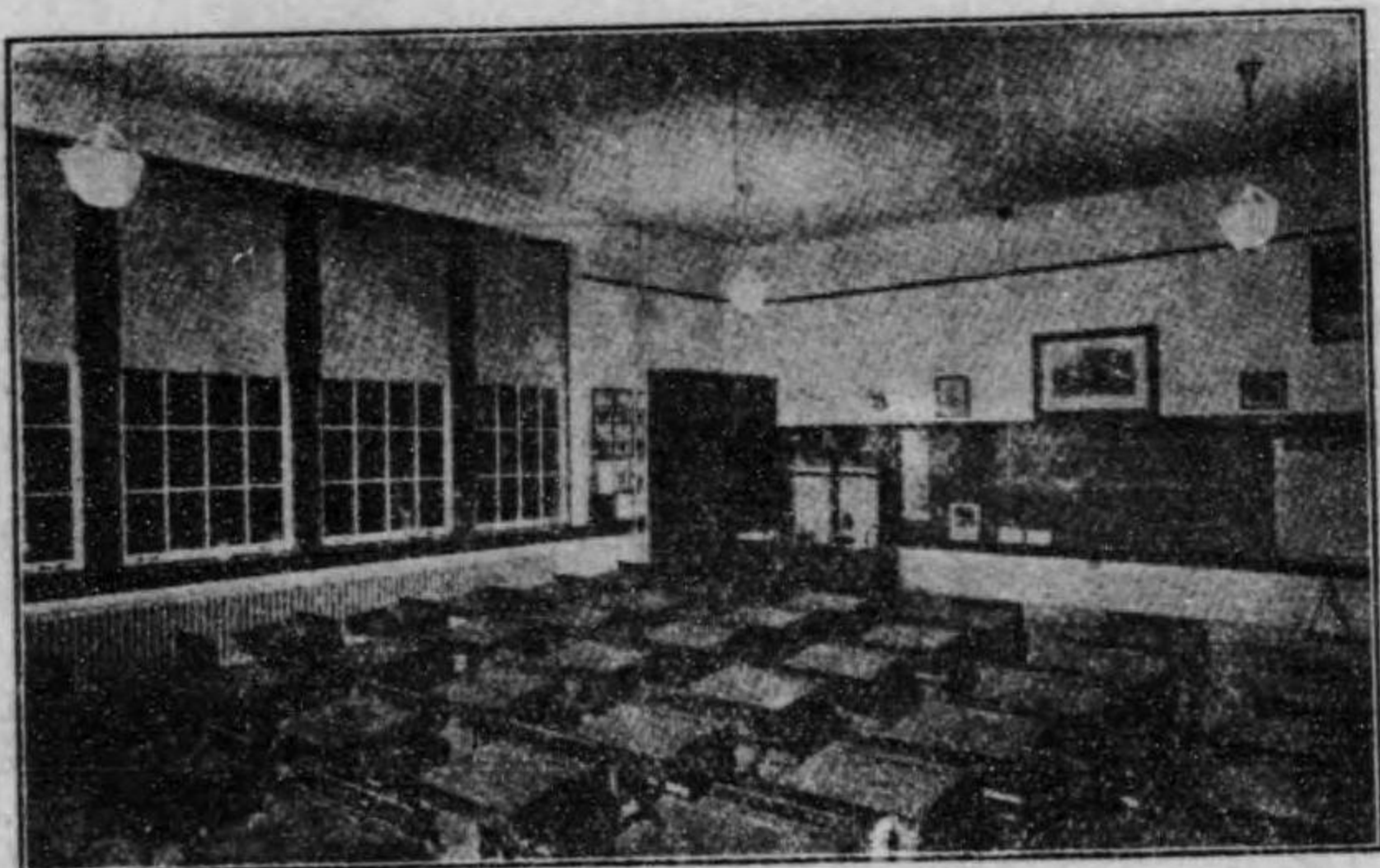
第三十三圖 スーダン反射笠第三〇三二號一四吋を使用したる教室の半間接照明
