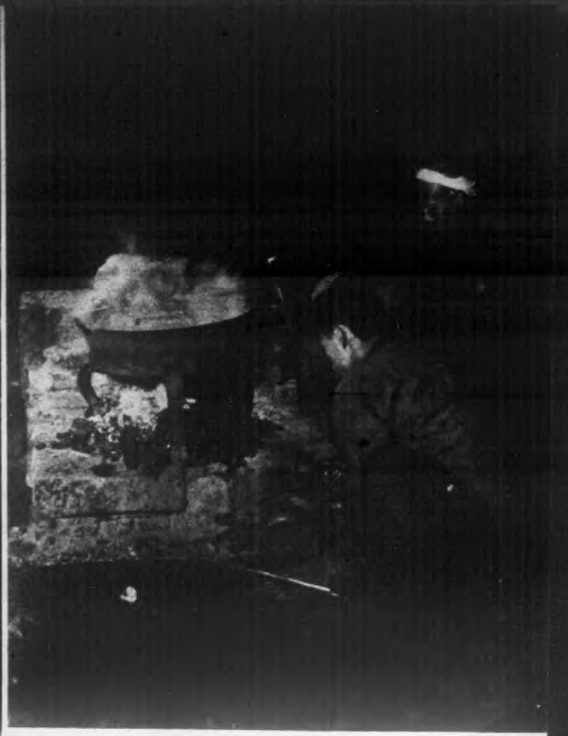
↑礦井裏有打鐵爐的設備，不斷的把掘煤工用鈍了的鎬尖，再打尖銳，這種工作叫作「尖鎬」。
