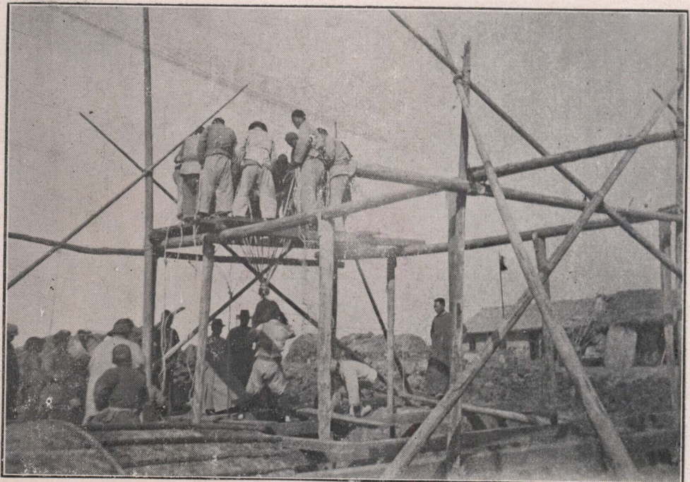
麗山湖實驗場築水閘基礎打樁之情形
