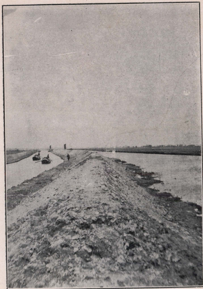
龐山湖實驗場挑挖灌溉總渠及建築土堤完成一部份後之情形
